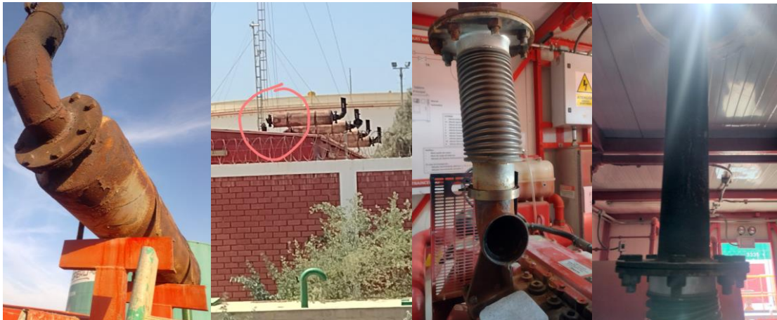
Instalación actual del sistema de escape de motores de bombas TZ-P1 y TZ-P2
