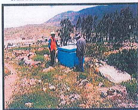
IMAGEN N° 5. CAMARA ROMPE PRESIÓN T-6 EN LA LÍNEA DE CONDUCCIÓN
