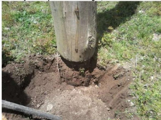
Postes con bases podridas que continuamente se desploman Fuente: Electrocentro S.A.
