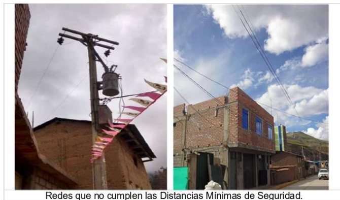
Fig. 7. Redes de media tensión incumplimiento distancias mínimas de seguridad
