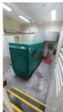
DISPOSICIÓN ACTUAL DE EQUIPO DE 125KW EXISTENTE (Largo: 298.50cm, ancho: 102.50cm, altura: 182.50cm)
