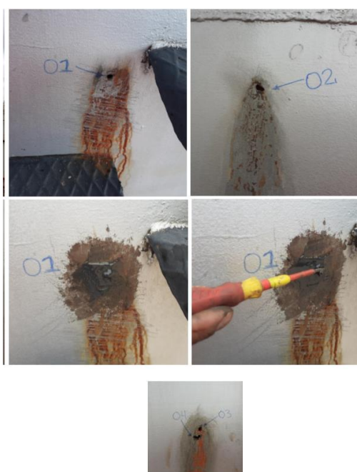
Figura N° 02: Fuga de agua presentadas
