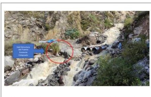
Imagen N° 03: (En la presente imagen se puede observar la estructura en deterioro) El Puente se presenta en condición de colapso total de la superestructura, encontrándose en muy mal estado
