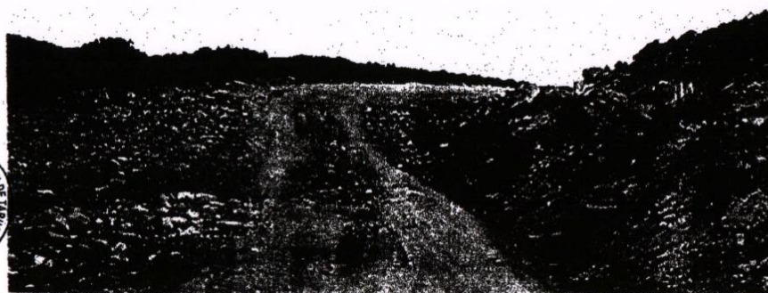
ÇFoto N° 03: Falla por presencia de baches (huecos) y acumulación de aguas pluviales
