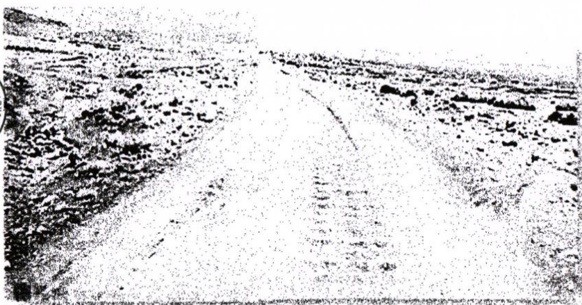
ÇFoto N° 03: Falla por presencia de baches (huecos) y acumulación de aguas pluviales
