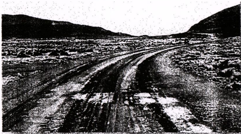
Foto N° 06: Quebrada del Río Cazador en la progresiva 20+660, presenta Badén de concreto colapsado, removido de su posición por el ingreso de avenidas en periodos de lluvias.
