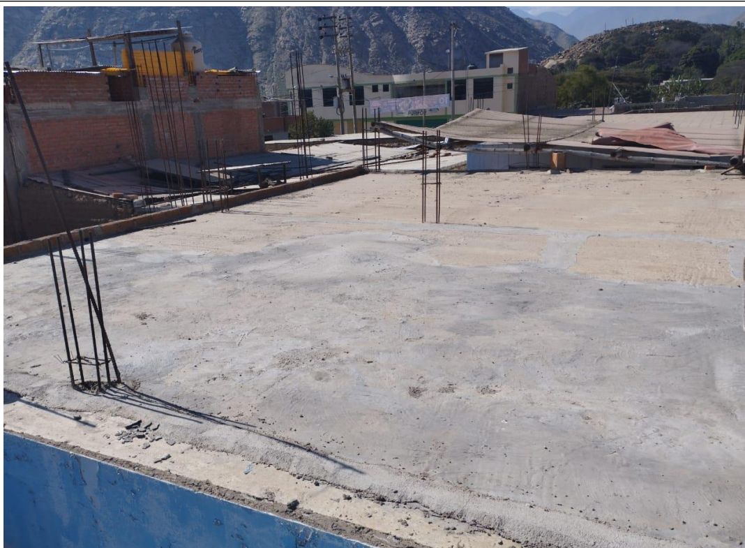
Fotografía N°06: Se observa el techo de concreto armado, con un material impermeabilizante inadecuado ante precipitaciones pluviales.
