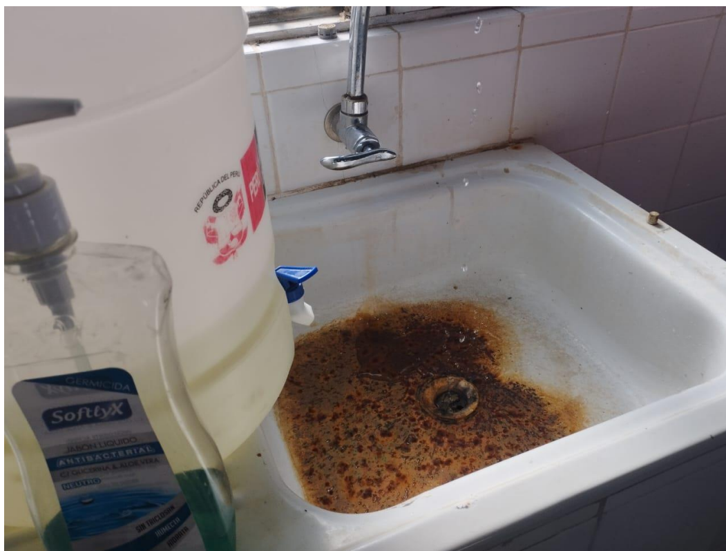
Fotografía N°07: Se observa las instalaciones de lavaderos con óxidos y sin funcionamiento.
