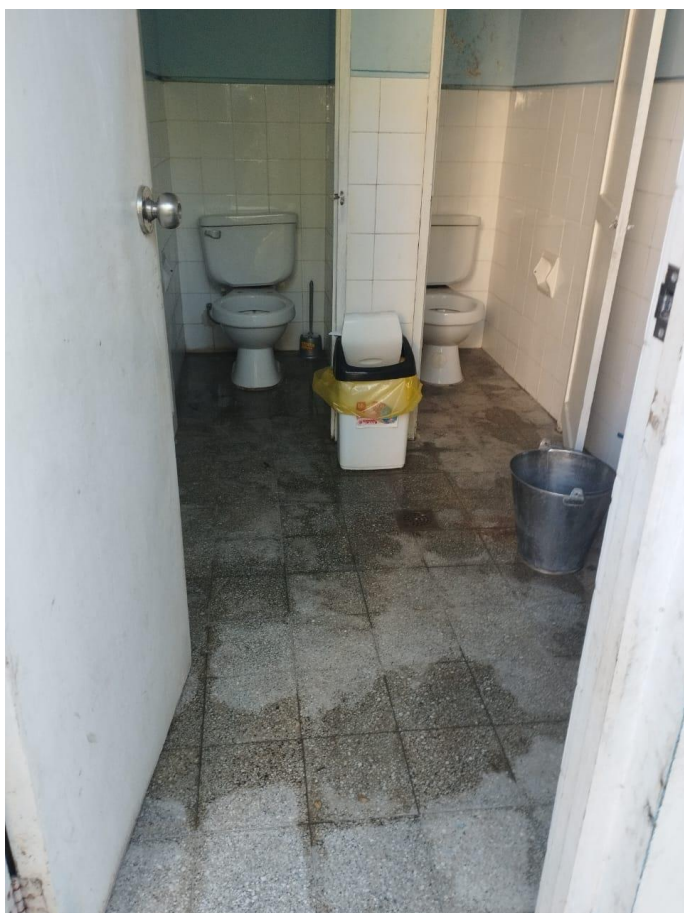
Fotografía N°11: Se observa fugas de agua e inoperatividad de los accesorios de los SS.HH.
