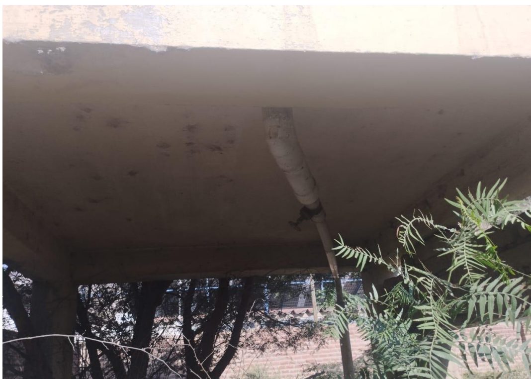
Fotografía N°10: Se observa los accesorios de instalaciones de agua potable del tanque elevado de concreto y el Rotoplas, presentan fugas e incorrecto funcionamiento.
