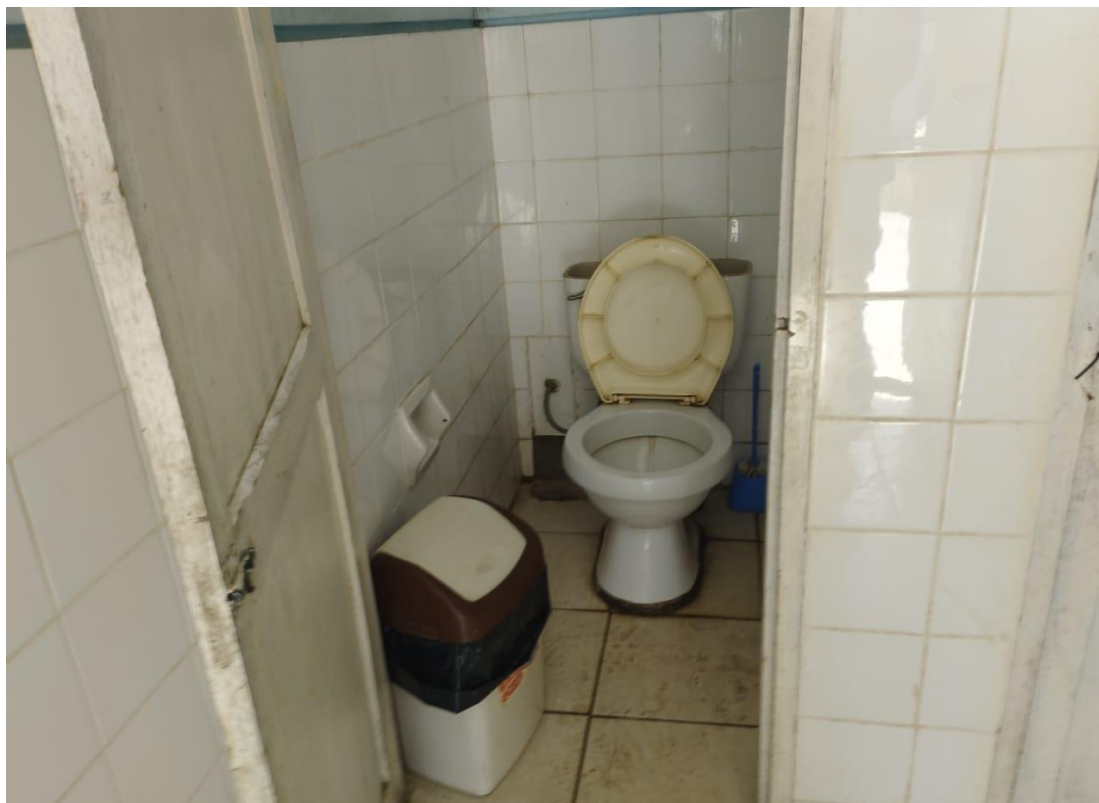
Fotografía N°11: Se observa fugas de agua e inoperatividad de los accesorios de los SS.HH.
