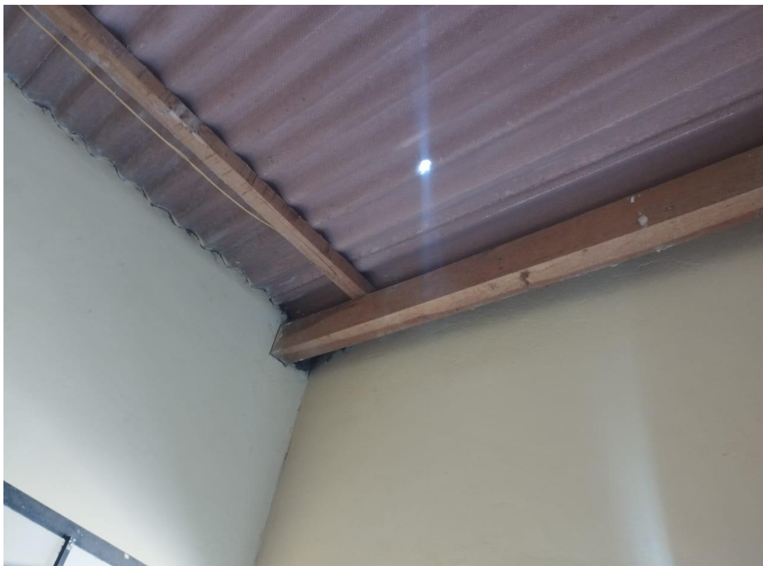
Fotografía N°05: Se observa agujeros en el techo de los ambientes de del puesto de Salud, el que no funcionó adecuadamente durante las precipitaciones pluviales.
