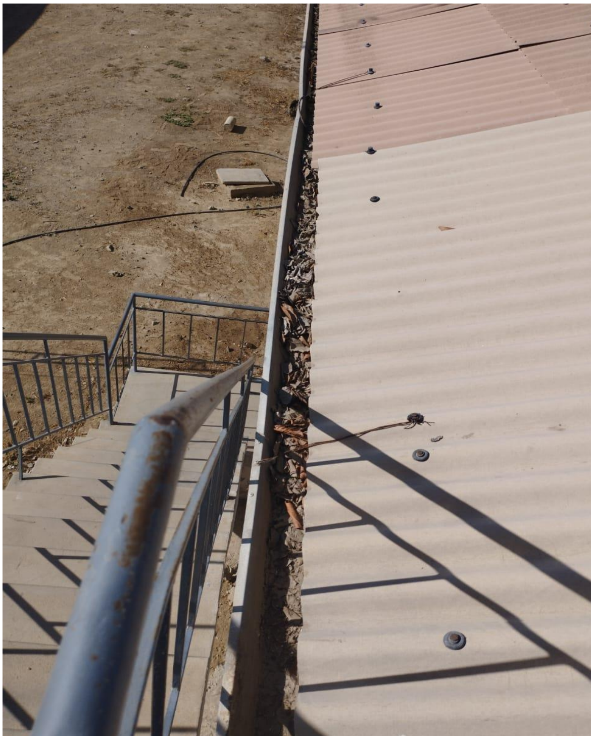
Fotografía N°02: Se observa sus canaletas de los techos con presencia de hojas secas de árboles y en estado de deterioro.
