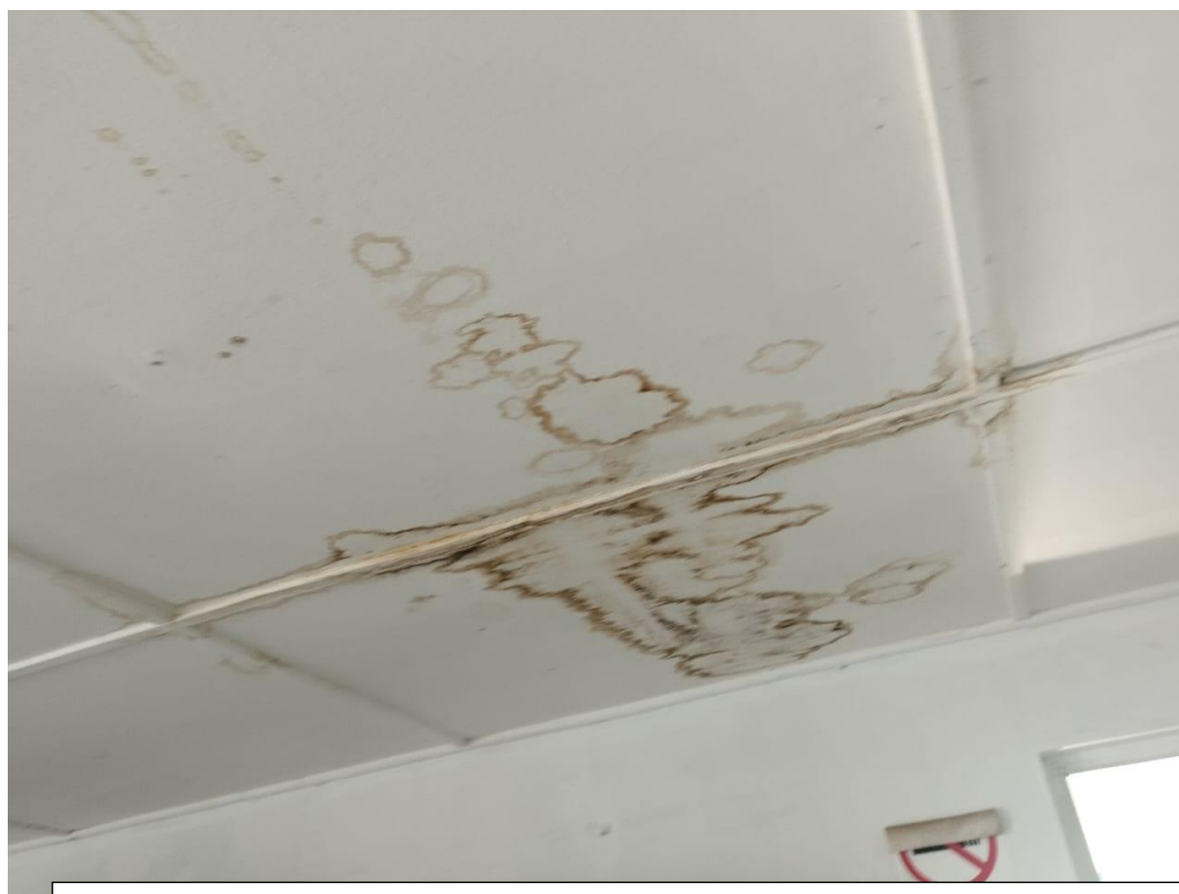
Fotografía N°04: Se observa húmedas en los cielos rasos de los ambientes del Puesto de Salud.
