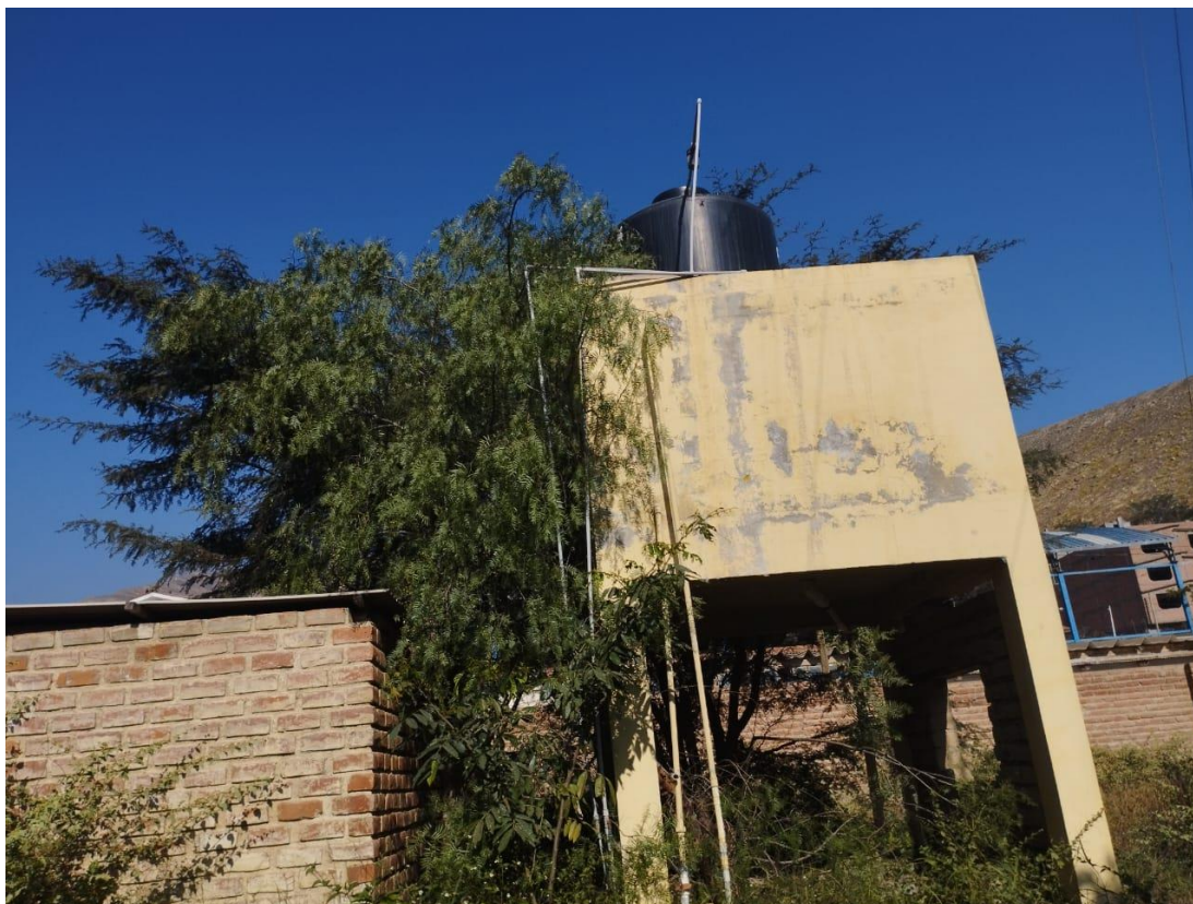
Fotografía N°09: Se observa el tanque elevado de concreto y el Rotoplas, se encuentran inoperativas.
