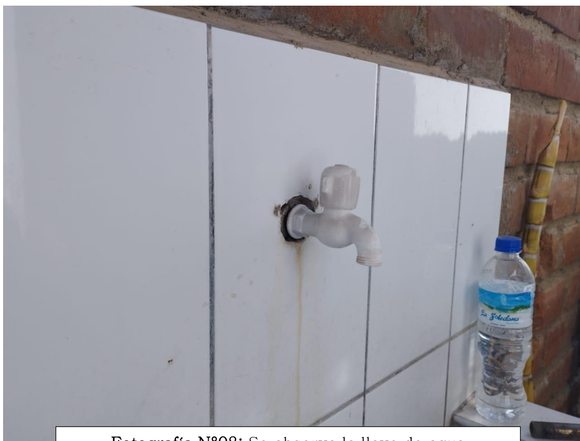
Fotografía N°08: Se observa la llave de agua inoperativo.
