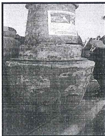
FIG.5 BASE DECONCRETO PARA LUMINARIAS DAÑADAS
