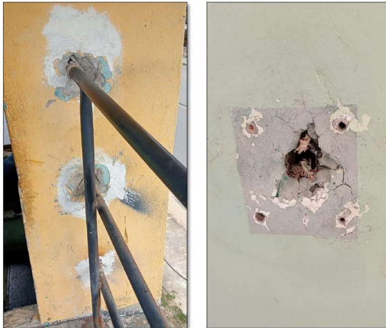
Imagen N° 5: Muro y cielorraso de torreón, en grietas y mal acabado.
