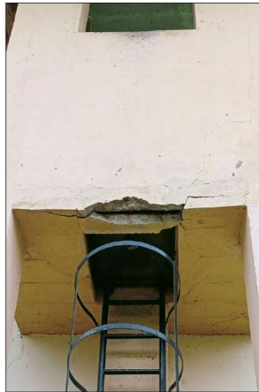
Imagen N° 8: Estructura de torreón con acero expuesto.
