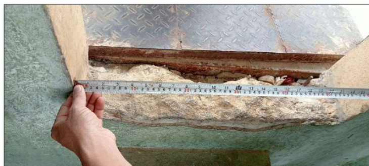
Imagen N° 6: Muro sardinel en deterioro. Necesita resane reforzado.
