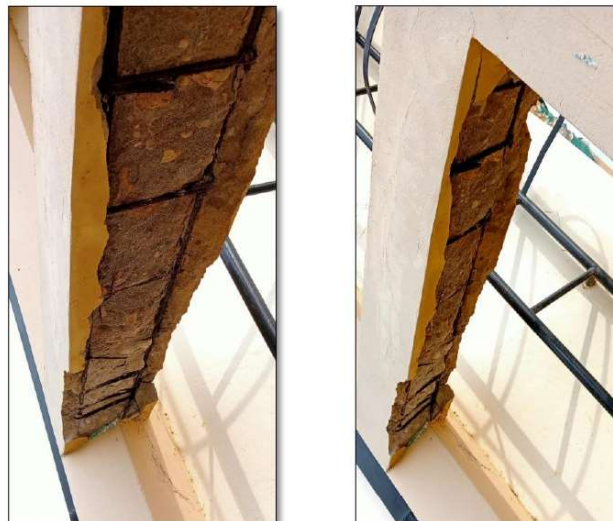
Imagen N° 2: Viga de torreón, abierta, oxidada propensa a desplomar.
