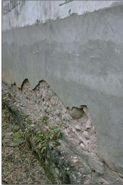
Imagen N° 3: Muro perimétrico con problemas de deterioro de su vestidura de tarrajeo.
