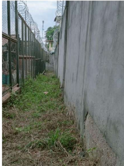
Imagen N° 1: Muro del cerco perimétrico, zona que urge refuerzo de dos columnas.
