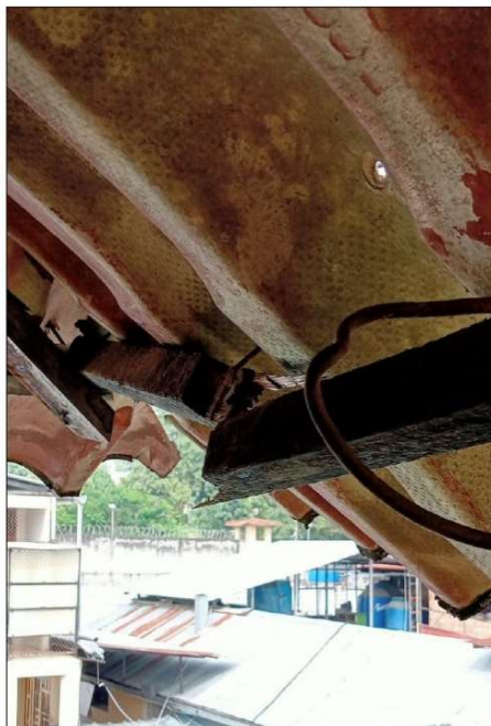
Imagen N° 09: Estructura de techo de torreón en condiciones de deterioro.
