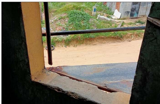
Imagen N° 10: Deterioro de estructura de pasarela, para cambiar.
