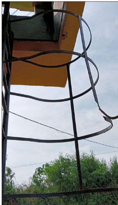
Imagen N° 11: Escalera de torreón en condición de deterioro.
