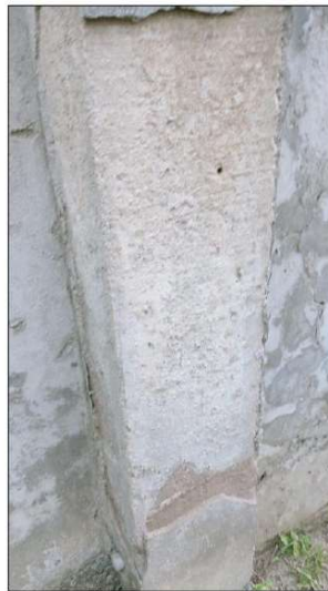
Imagen N° 4: Una de las columnas del cerco perimétrico, en desplome de su vestidura.
