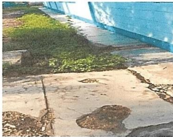
FOTO 04: SE OBSERVA DETERIORO EN LAS VEREDAS DE LOS CORREDORES EXTERIORES DEBIDO A LA FALTA DE UNA CANALETA Y/O CUNETETA DE EVACUACIÓN PLUVIAL
