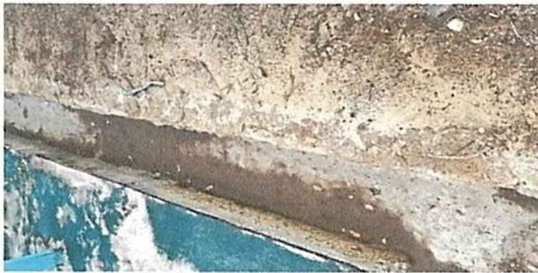
FOTO 03: CANALETAS Y MONTANTES PLUVIALES EN MAL ESTADO
