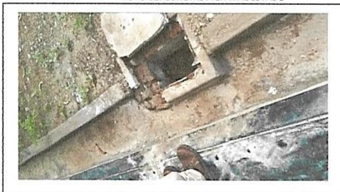
FOTO 02: PAREDES DE CUENTAS DETERIORADAS
