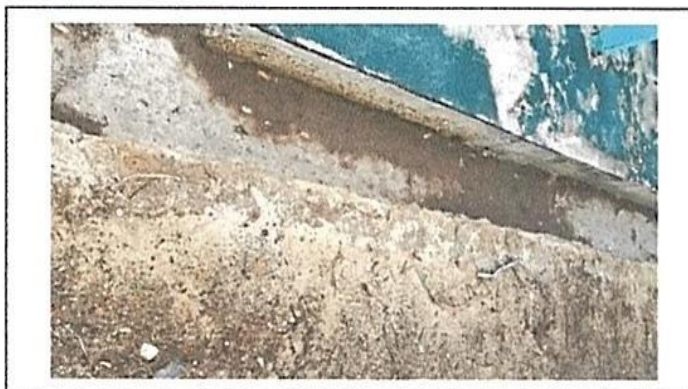
FOTO 01: CUNETAS A EN MAL ESTADO
