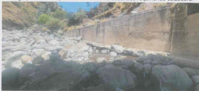
Fotografía 04: Se observa la socavación de los muros de encausamiento el mismo requiere calzadura.
