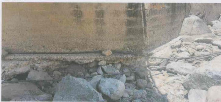
Fotografía 03: se observa la socavación en los estribos
