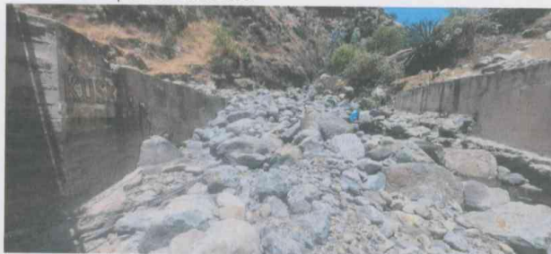
Fotografía 05: Se observa que requiere descolmatación aguas arriba
