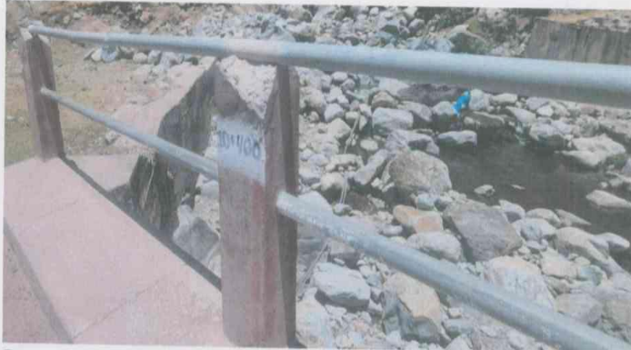
Fotografía 01 – se observa deterioro de barandas.
