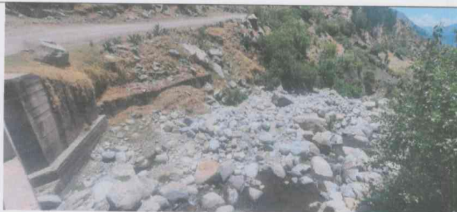
Fotografía 05: Se observa que requiere descolmatación aguas abajo
