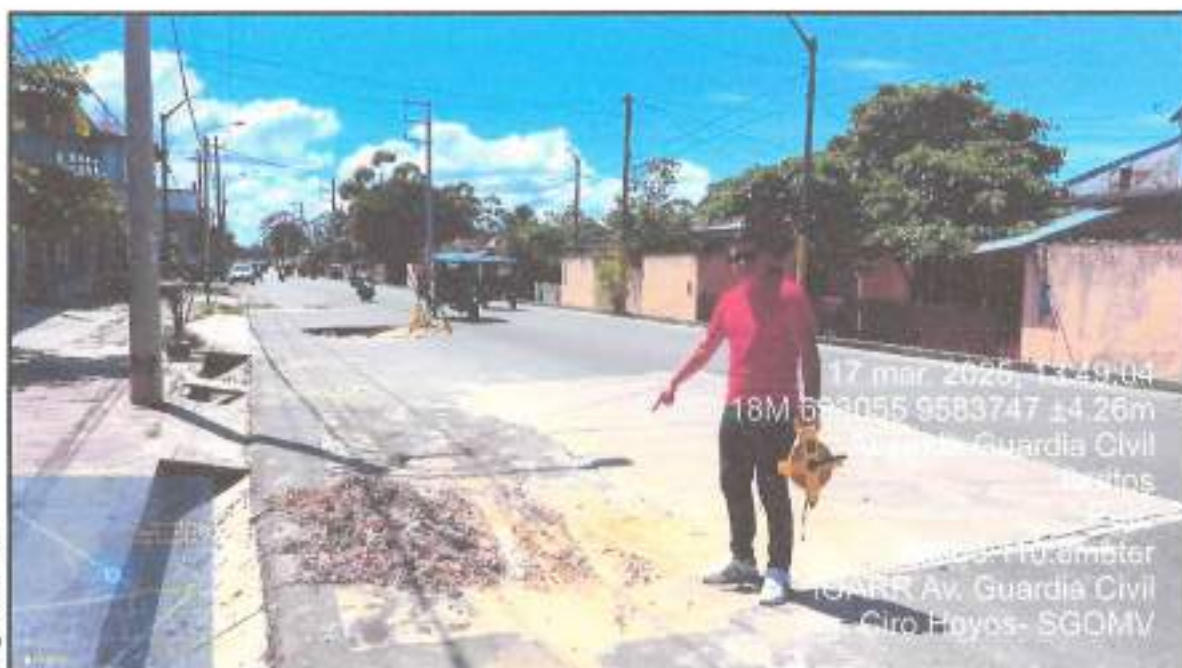
FOTO N° 02. AV. GUARDIA CIVIL PRESENTA HUNDIMIENDO EN TRAMOS A CAUSA DE LAS INTENSAS LLUVIAS.
