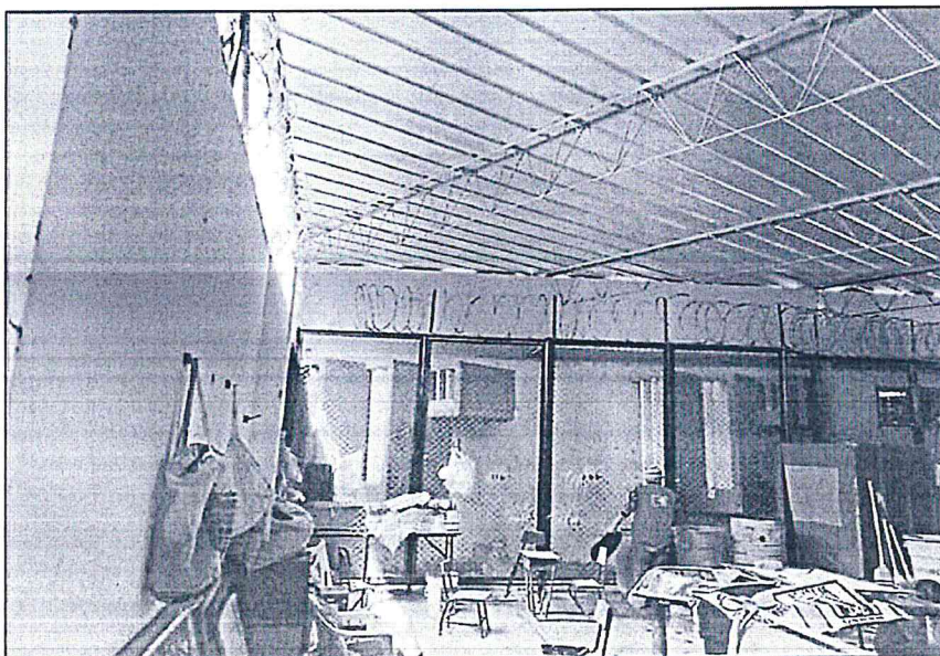
Concertinas en mal estado, rotas, dejando tramos vulnerables en talleres
