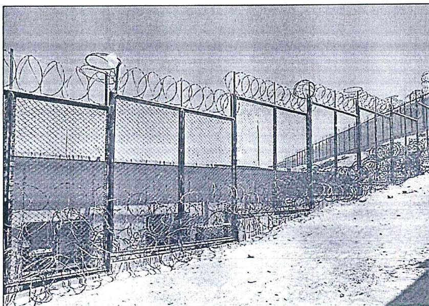
Cerco de mallas con poca altura y con una sola hilera de concertinas.
