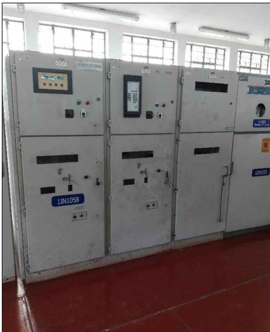
Figura N° 1. Celdas de 10kV marca SIEMENS deterioradas.
