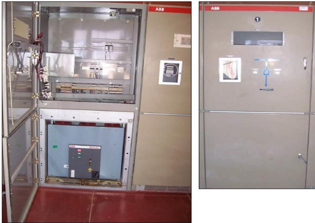
Figura 1. Celdas de 10 kV marca ABB deteriorada
