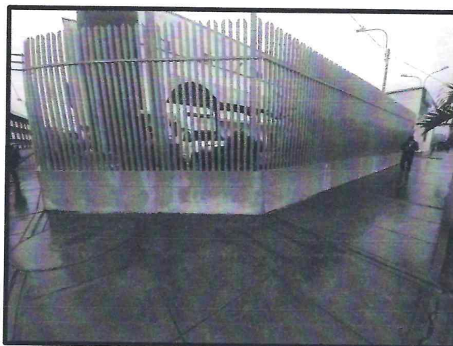
FOTO 06 – Se observa en la imagen el deteriorado estado en la que se encuentran el pintado del contrazocalo exterior del establecimiento de salud.
