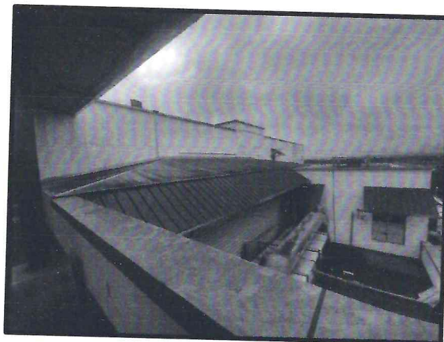
FOTO 09 – Se observa en la imagen uno de las coberturas en el cual existente goteras que perjudican a los trabajadores y pacientes.
