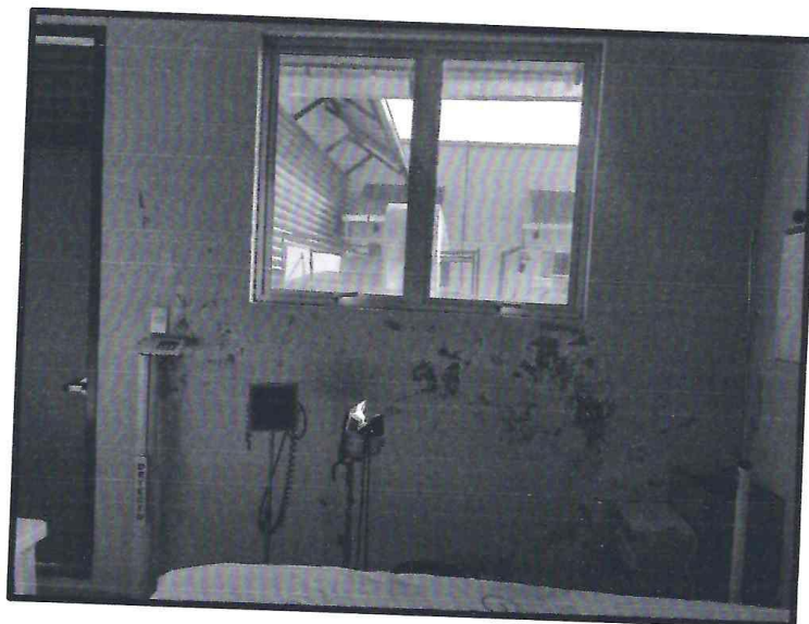
FOTO 13 – Se observa en la imagen un ambiente interior que debido al mal estado del techo perjudico la pintura del mismo.
