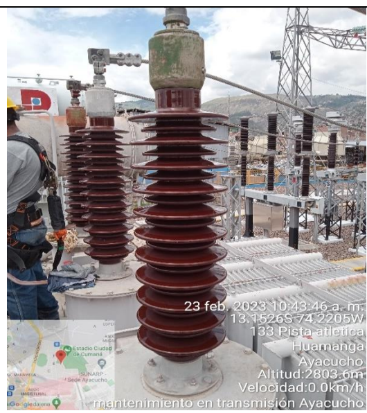
Foto N°05: Limpieza de transformador 4-TP-202 (Bushing de alta)
