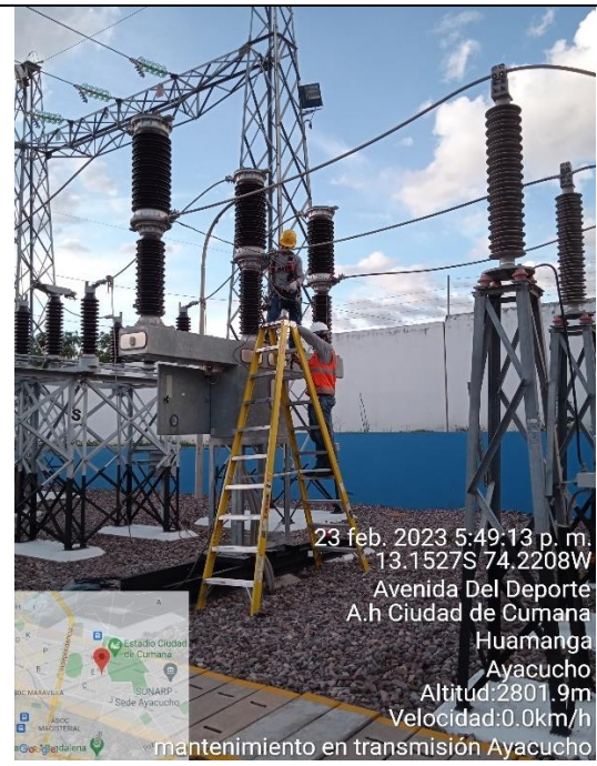
Foto N°07: Limpieza del Interruptor de potencia 4IN-066-202
