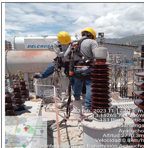
Foto N°04: Limpieza de transformador 4-TP-202
