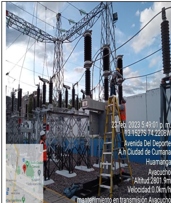
Foto N°06: Limpieza del Interruptor de potencia 4IN-066-202
