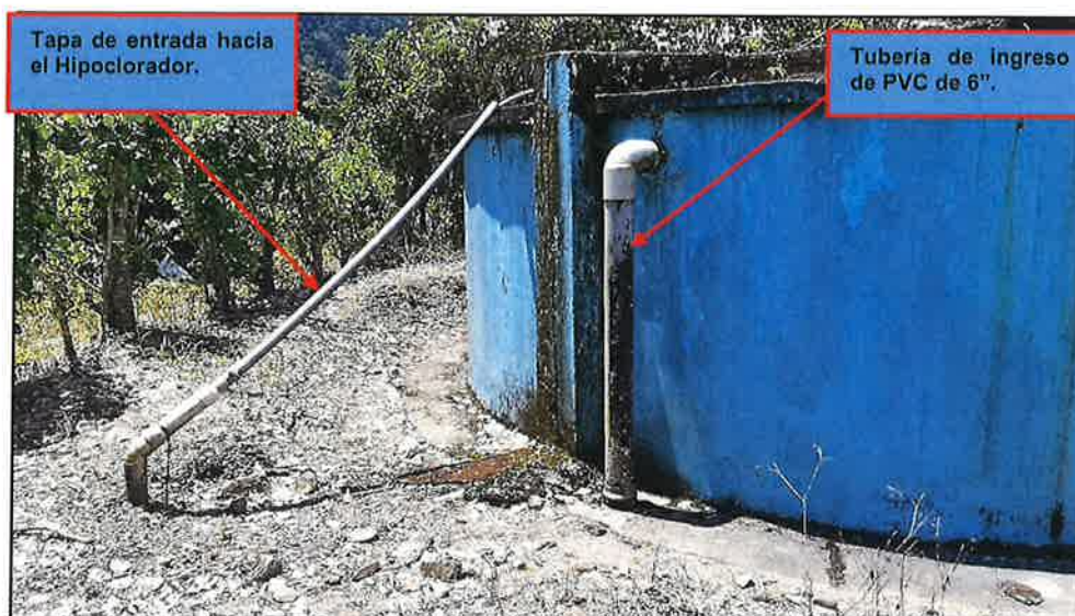
Fotografía N° 13: Estado del Reservorio Apoyado.
