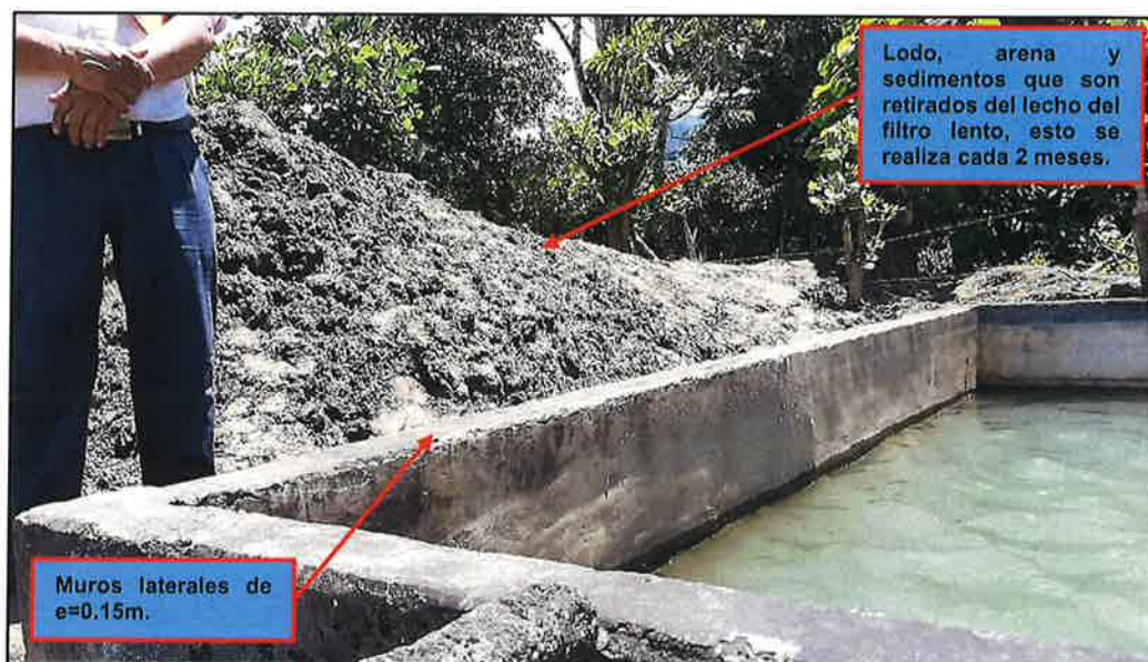
Fotografía N° 10: Estado del Filtro Lento de Arena.
