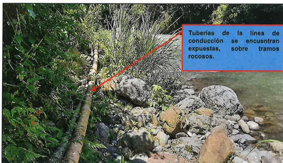
Fotografía N° 6: Estado de la línea de conducción.
