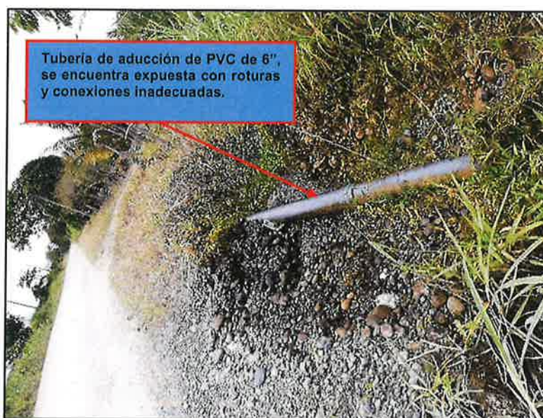
Fotografía N° 14: Estado de la línea de aducción.
