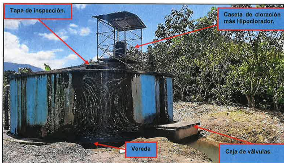
Fotografía N° 12: Estado del Reservorio Apoyado.
