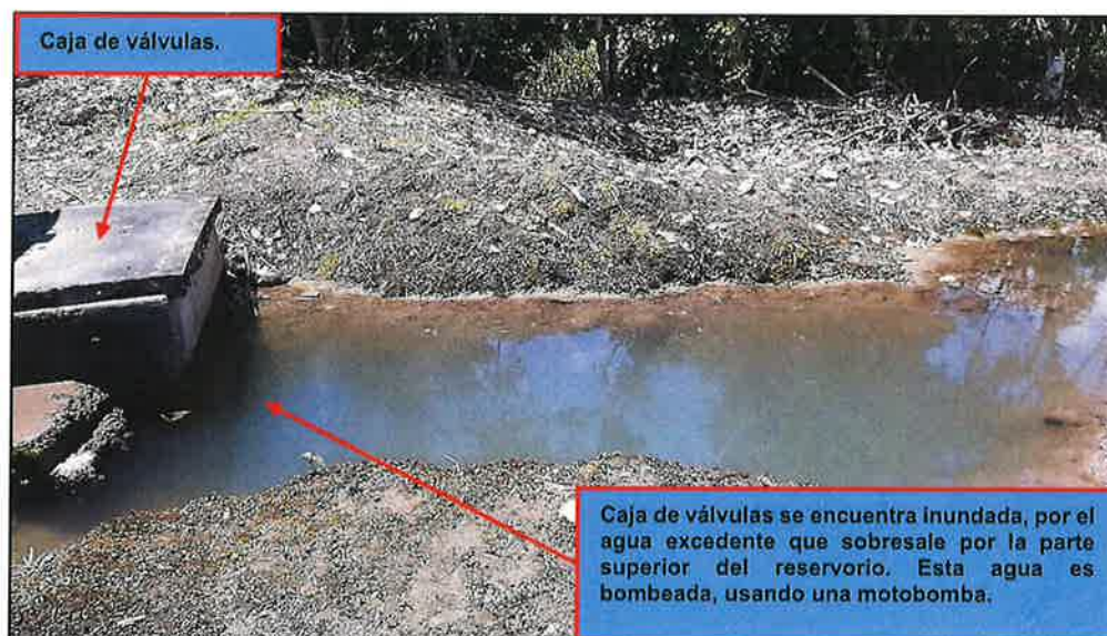
Fotografía N° 12: Estado del Reservorio Apoyado.
