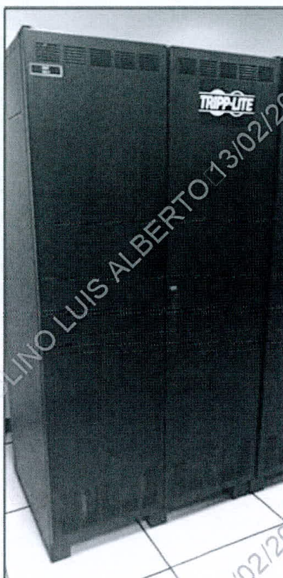
Figura N°2 – Banco de Baterías BP480V400
