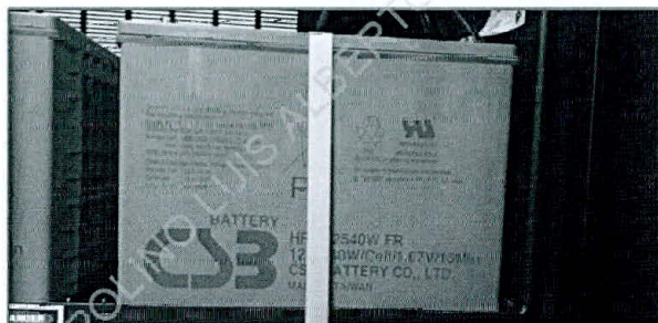
Figura N°1 – Batería de 12v y 540W HRL125040W
