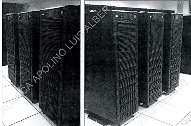
Figura N°3 – Gabinetes UPS 3F SU120KX2 Ramal 1 (izquierda) y Ramal 2 (derecha)
