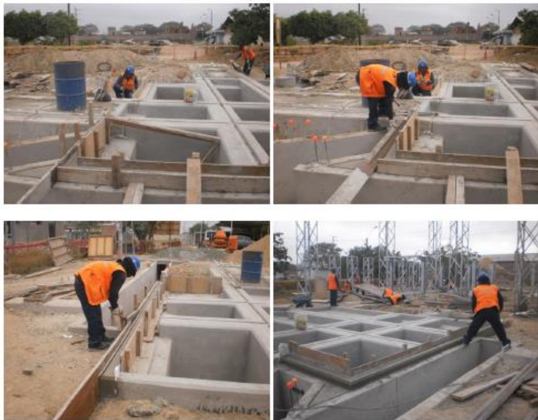
Construcción final de modificaciones de muro de la poza de derrame de aceite del Transformador de Potencia para ampliar la parte superior
