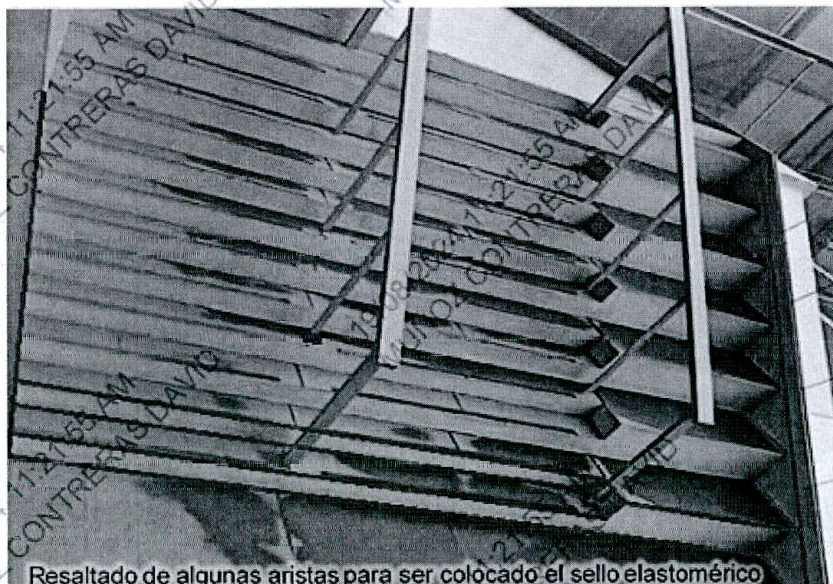
Resaltado de algunas aristas para ser colocado el sello elastomérico
