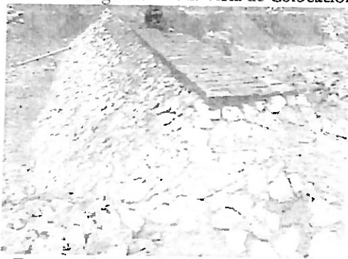
Figura N° 4. 2: Vista de Colocación de Piedra en Talud Aguas Arriba y Abajo
