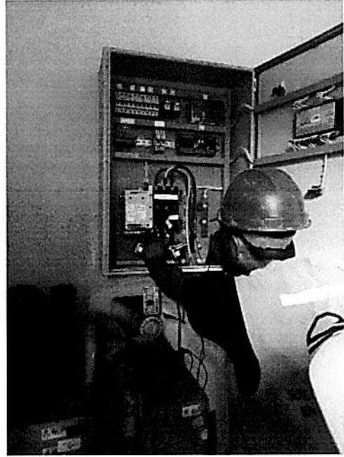
Fotografías N° 03: Tablero de transferencia automática
