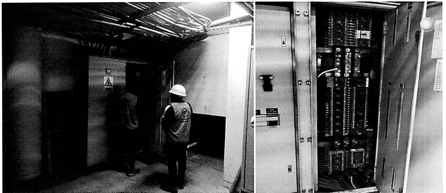
Fotografías N° 05: Tablero de distribución en baja tensión con evidente falta de mantenimiento.
