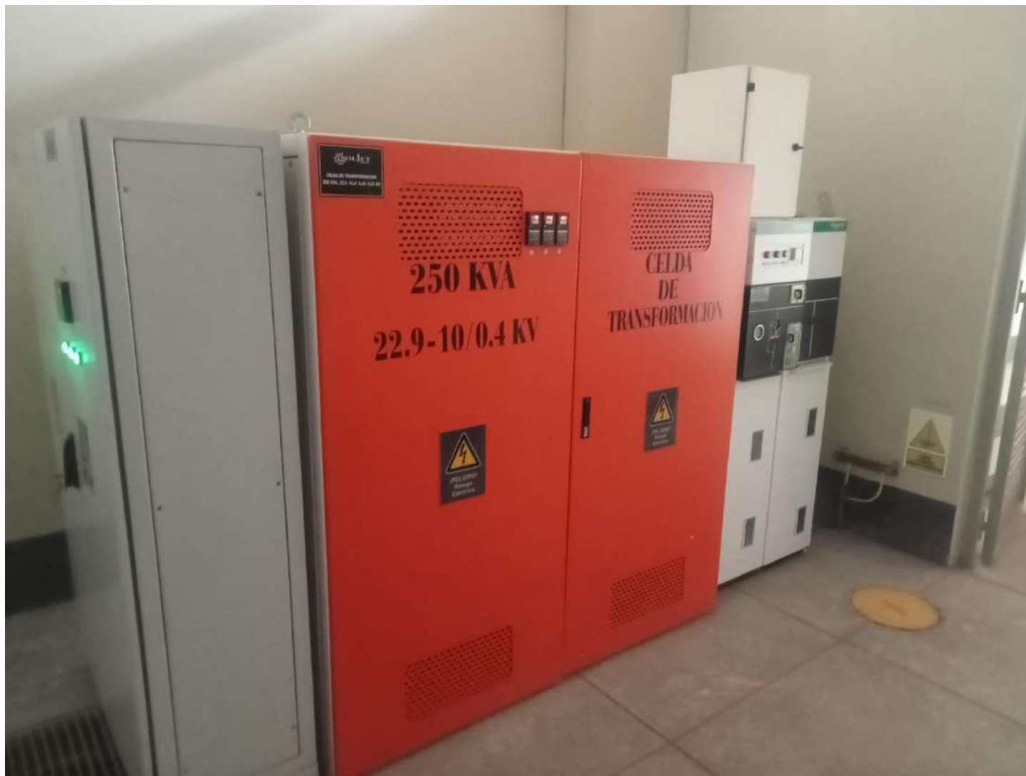
Fotografías N° 01: Estado de subestación tipo caseta y tablero general
