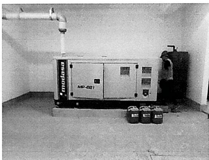
Fotografías N° 03: Grupo Electrónico MODASA 83 Kw
