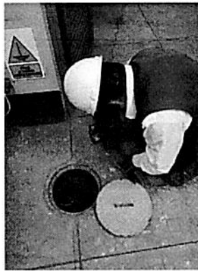
Fotografías N° 07: Sistema de puesta a tierra.
