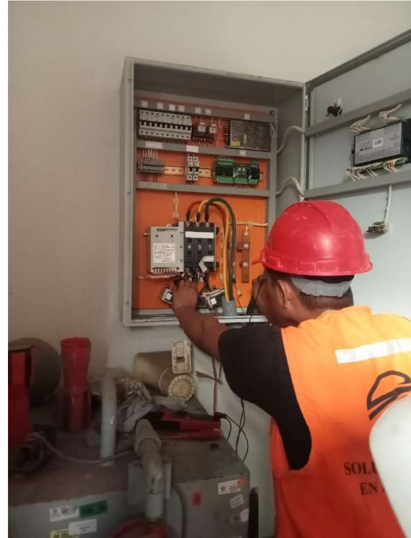
Fotografías N° 03: Tablero de transferencia automática
