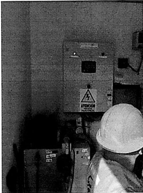
Fotografías N° 03: Tablero de transferencia automática
