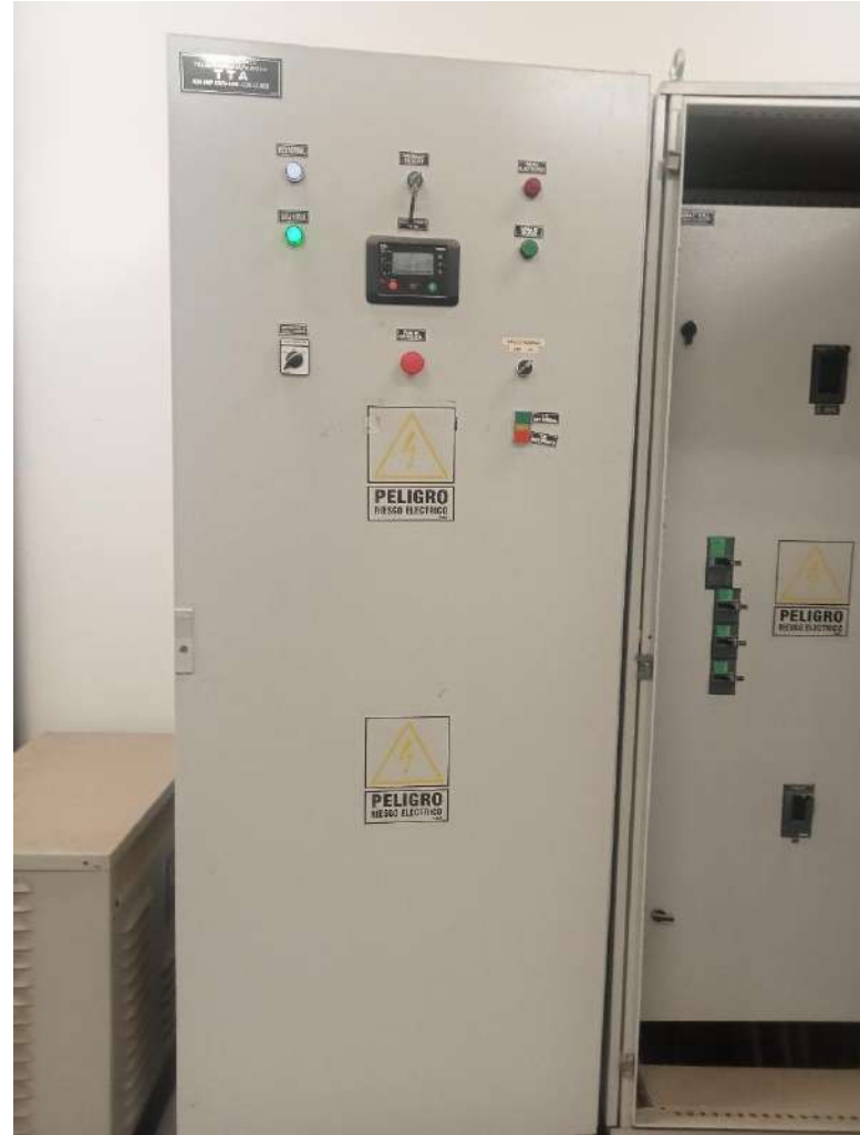
Fotografías N° 04: Tablero de transferencia automática, general y de distribución
