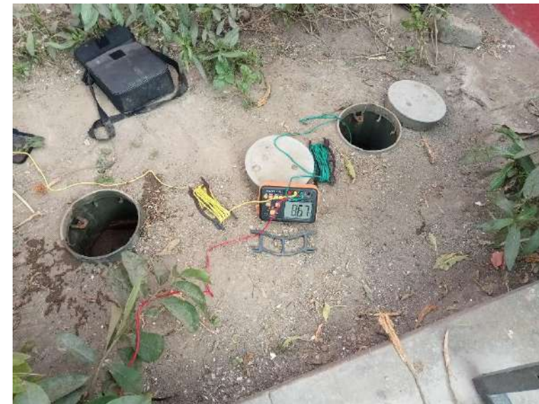
Fotografías N° 08: Estado de los pozos a tierra.
