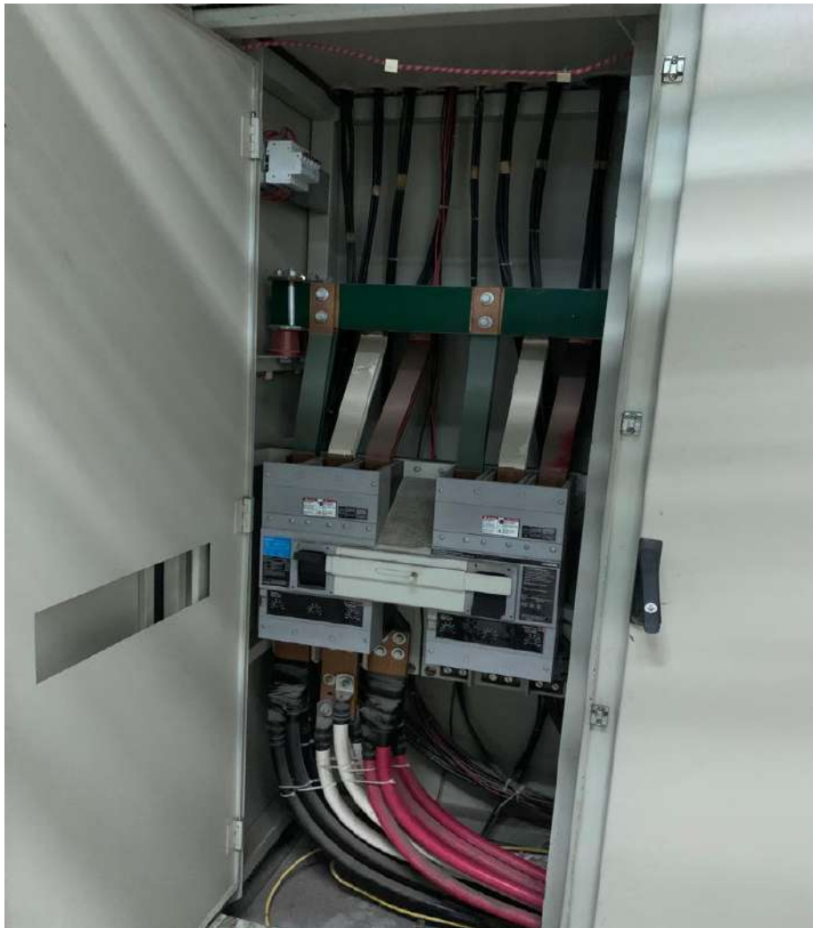
Fotografías N° 06: Tablero de distribución en baja tensión con evidente falta de mantenimiento.
