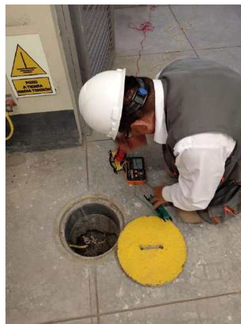
Fotografías N° 07: Sistema de puesta a tierra.
