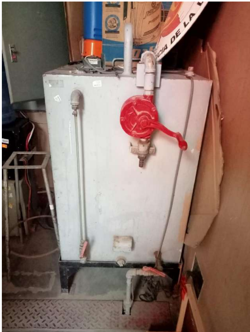
Fotografía N° 07: Tanque de combustible. Necesita mantenimiento preventivo contra la corrosión
