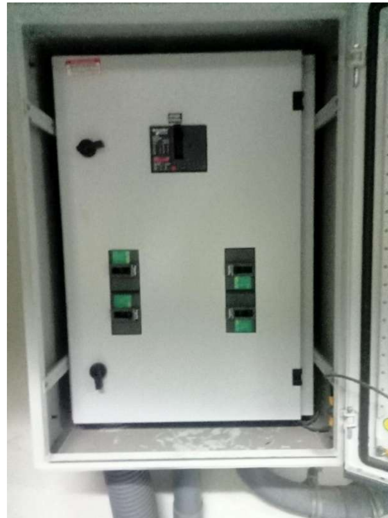
Fotografías N° 06: Tablero de distribución en baja tensión con evidente falta de mantenimiento.
