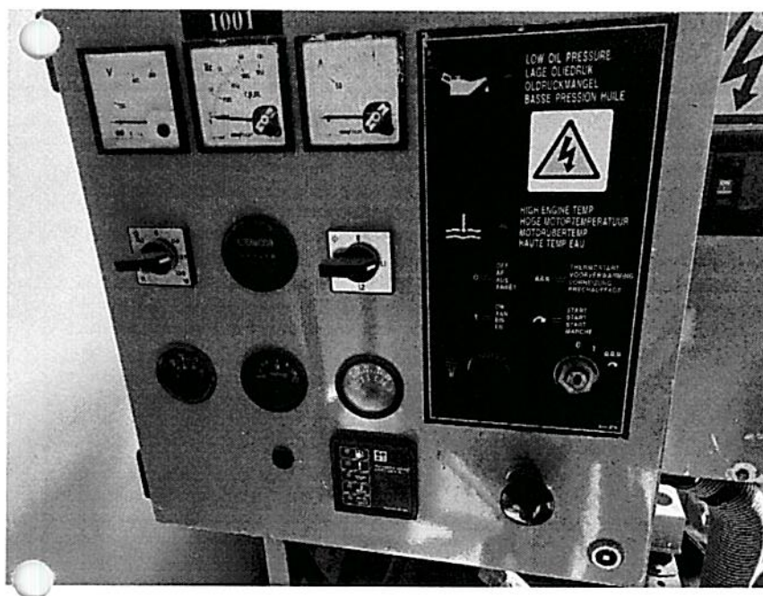
Fotografías N° 02: Tablero de control e indicadores en buen estado.
