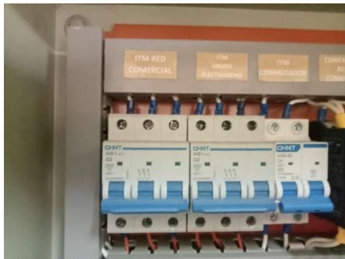
Fotografías N° 03: Tablero de Transferencia Automática, se encuentra en buen estado
