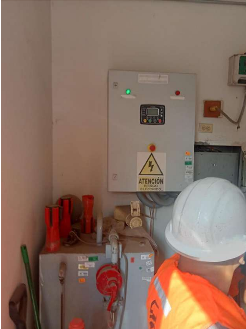
Fotografías N° 03: Tablero de transferencia automática
