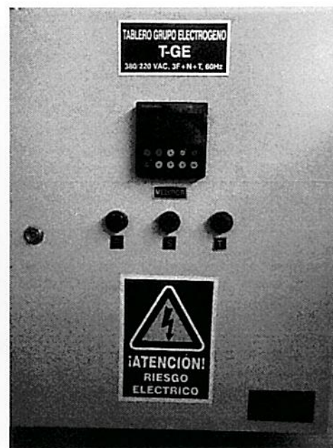
Fotografías N° 02: Estado de tablero de subestación, tablero general, tablero de grupo electrógeno
