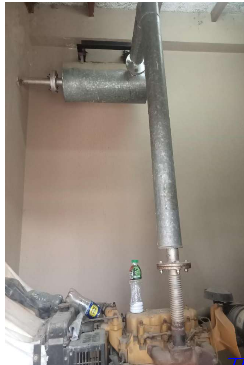
Fotografías N° 06: Tanque de combustible, mangueras, carcasa y ductos de expulsión de gases.
