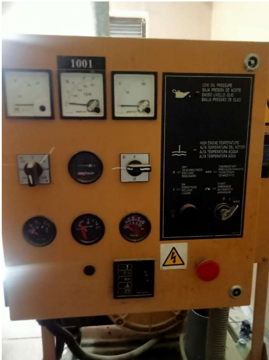
Fotografías N° 05: Indicadores de voltaje, frecuencia, intensidad de corriente, nivel de aceite, nivel de combustible, horómetro.
