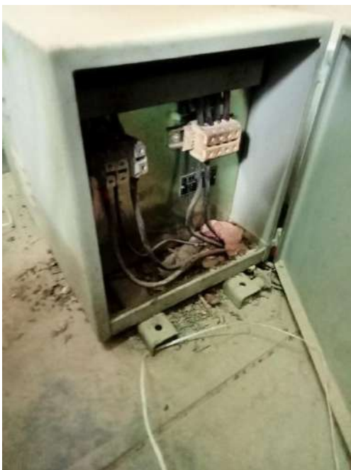
Fotografías N° 04: Tablero general y transformador de aislamiento.
