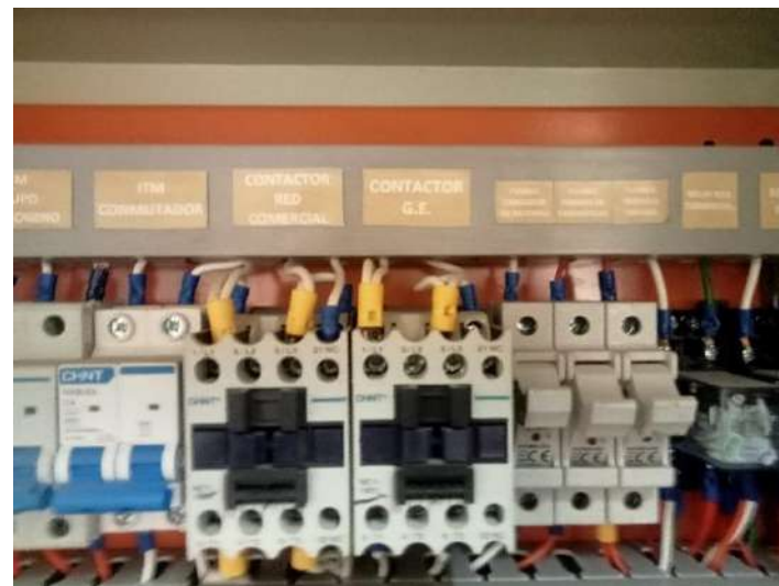
Fotografías N° 03: Tablero de Transferencia Automática, se encuentra en buen estado
