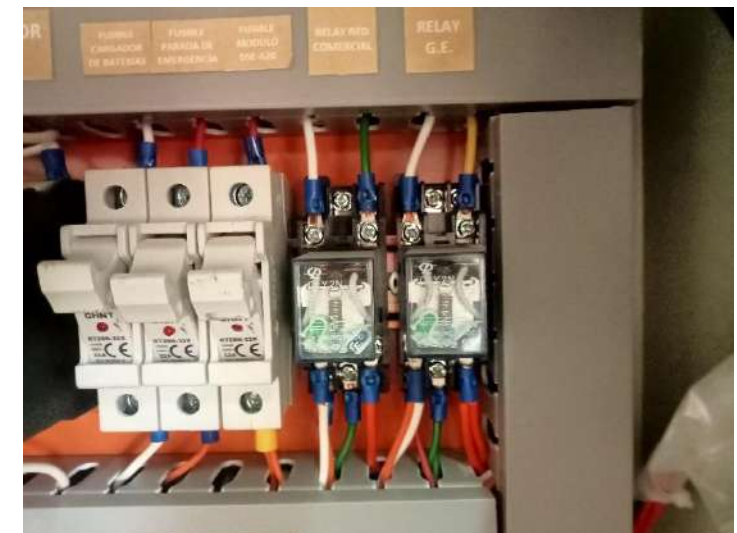
Fotografías N° 03: Tablero de Transferencia Automática, se encuentra en buen estado
