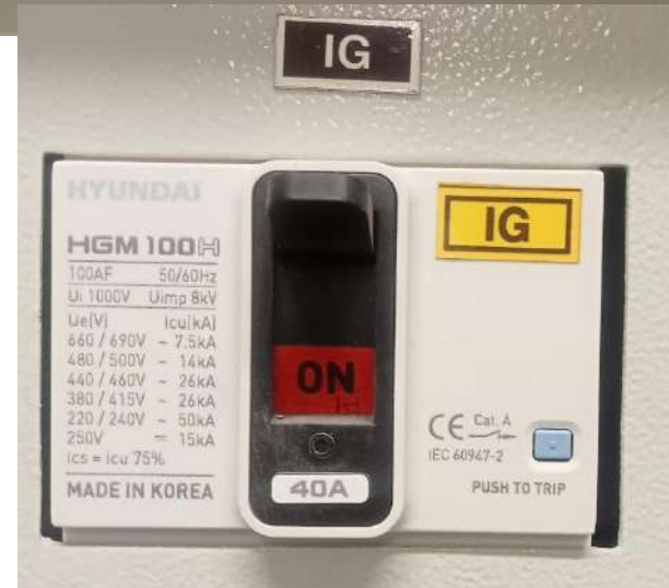
Fotografías N° 05: Buen estado funcional de breakers e interruptores.
