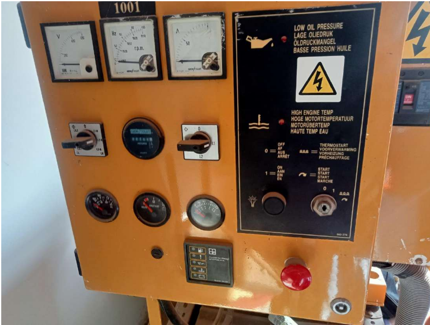
Fotografías N° 02: Tablero de control e indicadores en buen estado.
