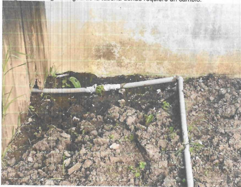
Imagen N° 5: Fuga de agua de la tubería donde requiere un cambio.
