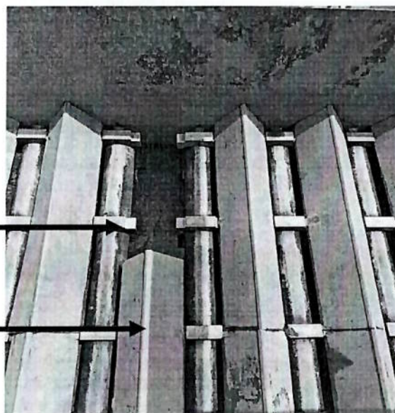
FIG N° 02- B: Entre dos tubos, en el centro se ubica las Planchas Tranquilizadoras
