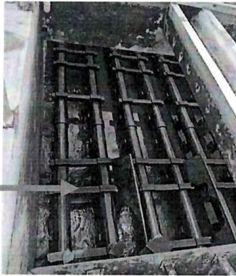
FIG. N° 02 – C: Soporte móviles de concreto, soporte de Planchas Tranquilizadora. Cada fila de 02 tubos, comprende 07 unidades de soporte movable.
