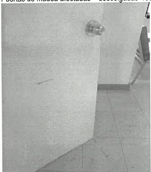
Puertas de madera afectadas – descolgadas- requieren mantenimiento gral.
