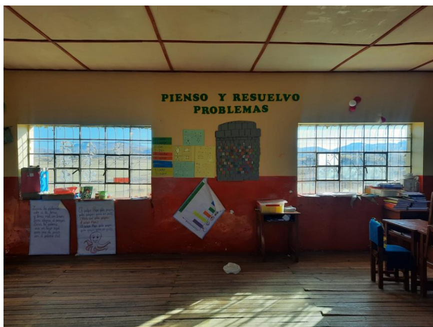
Imagen N°02: Al interior del aula del 1° y 2° grado, piso machihembrado en mal estado, falso cielo raso en regular estado.
