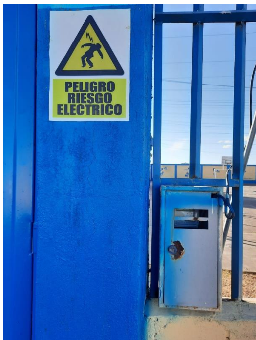
Medidor de la parte eléctrica en el cerco exterior, mientras que el tablero general se encuentra al interior del aula del 1° y 2° grado del módulo A.
