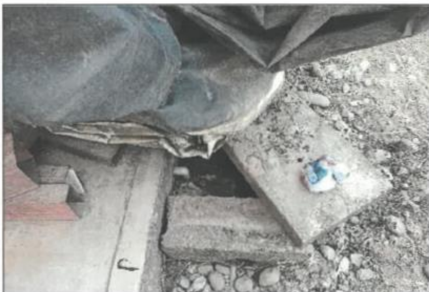
FOTO N°12: Vista preliminar de la situación actual de la zona a acondicionar los ambientes. CAJA DE AGUA A DESMONTAR Y REPONER
