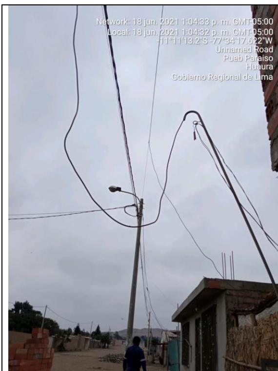
Acometidas con tubos en mal estado, oxidados o doblados.
