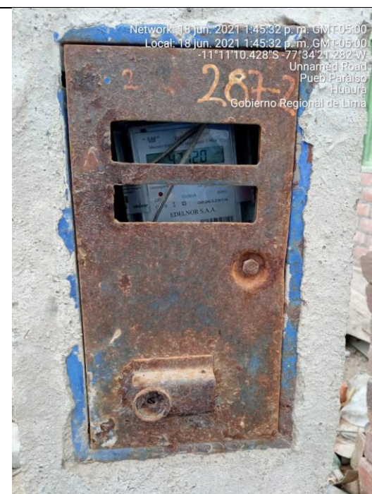
Acometidas en mal estado.
