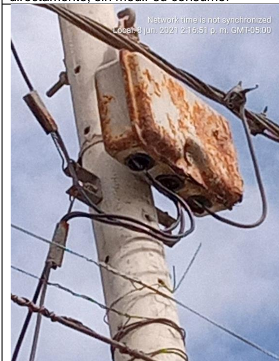
Caja de derivacion en estado de oxidacion
