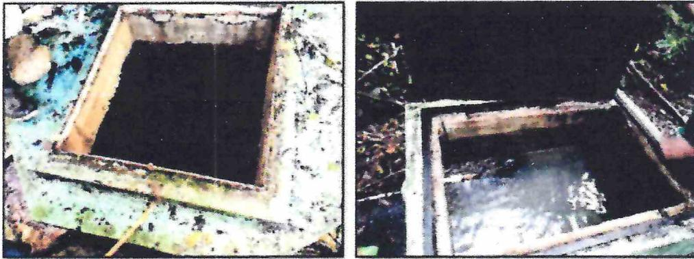
Foto N° 07 y 08.- Se aprecia el actual estado de las cámaras rompe presiones tipo 7.
