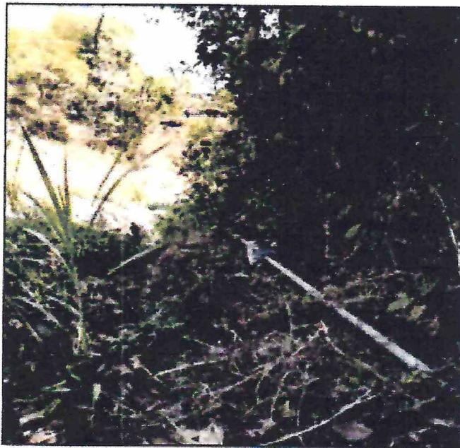
Foto N° 14, tuberías de la línea de conducción se encuentran expuestas y con parches, presentan pequeñas fugas de agua
