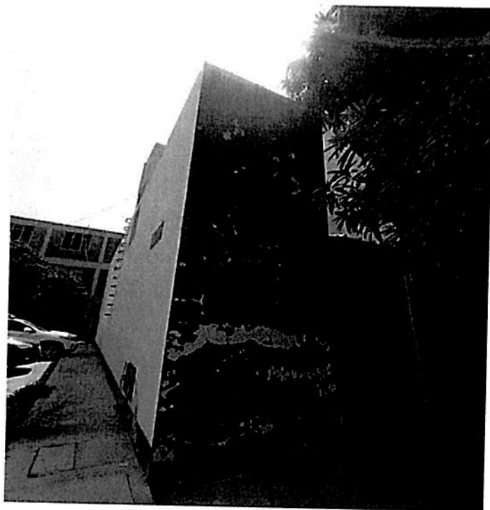
Acabados de pintura deteriorados por la humedad
