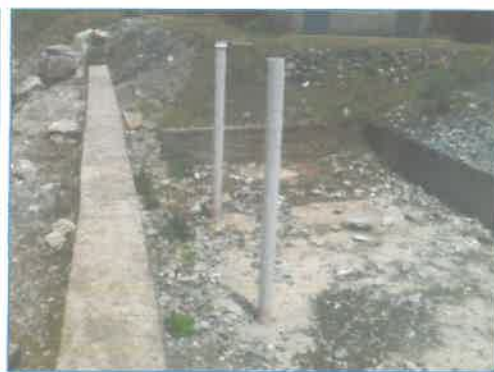
ventilaciones del Tanque séptico
