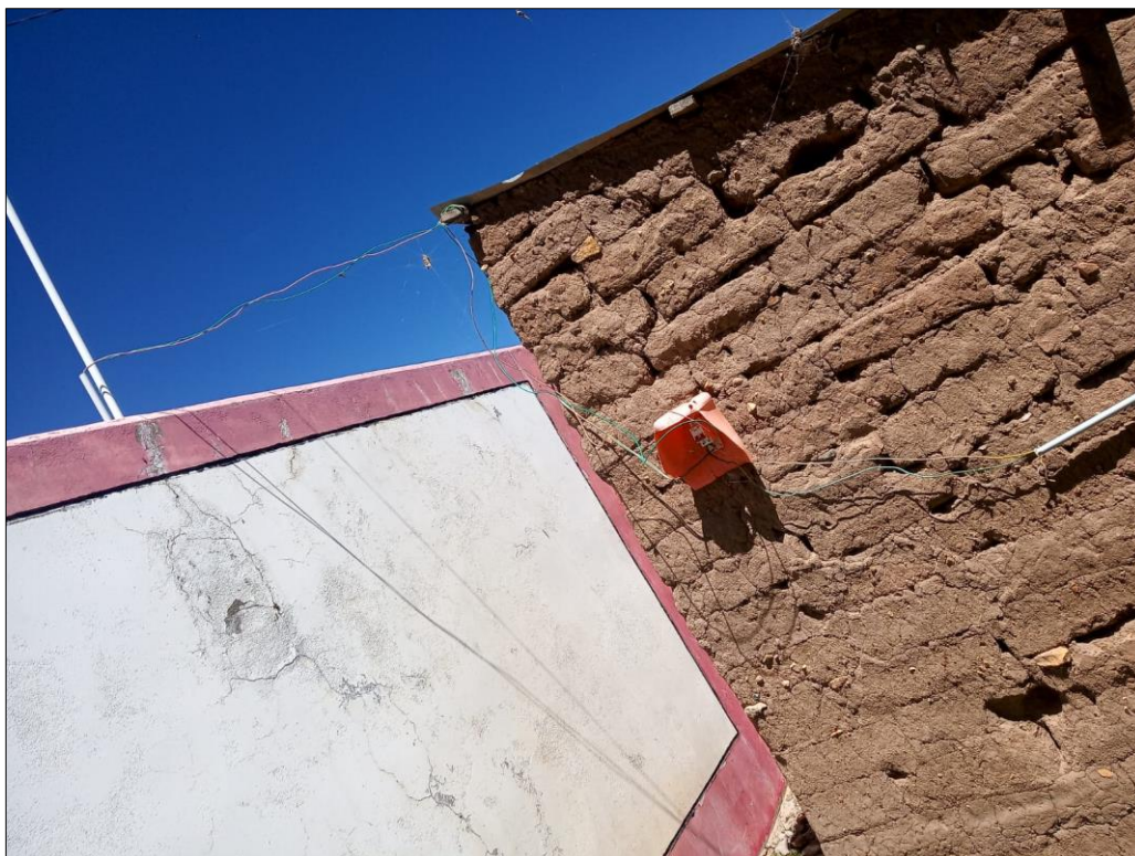
Fotografía 08: Vista del medidor empotrado en el muro perimétrico del local educativo, con salida aérea hacia un termomagnético ubicado en un muro de adobe, que hace las veces de un tablero general.
