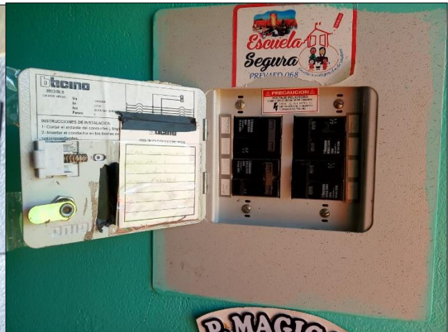
Fotografía 11: vista interior de los tableros de distribución de las aulas
