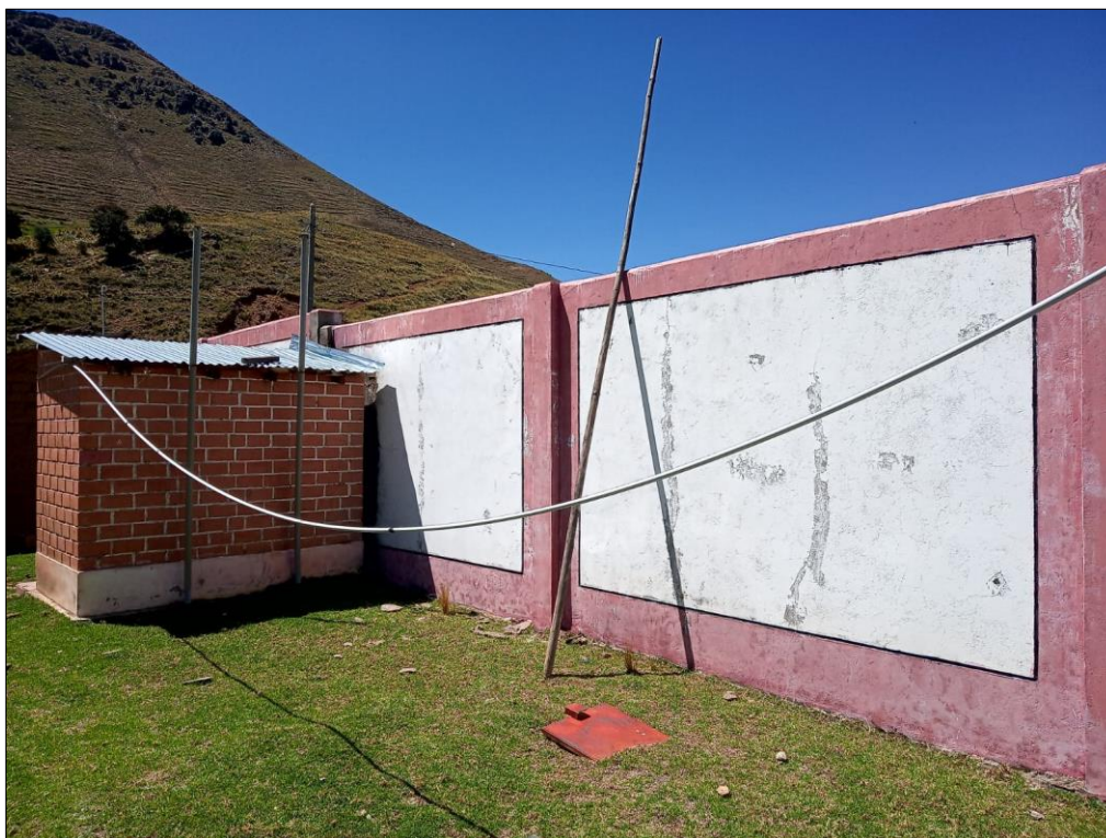
Fotografía 09: Alimentación eléctrica aérea entubada hacia los tableros de distribución de los pabellones 01 y 02.
