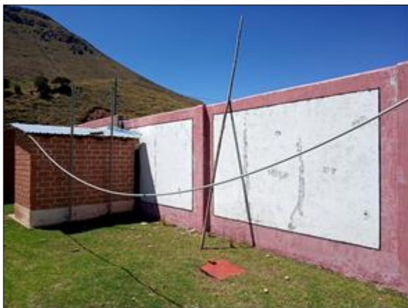
Acometida aérea entubada hacia los tableros de distribución TD1 y TD2 de os pabellones de las aulas.
