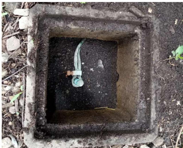
Fig. N° 28 UBICADO EN LA PARTE POSTERIOR, COSTADO DERECHO, PRESENTA CAJA DE CONCENTRO SIN PINTAR A 3 METROS DE LA ANTENA DE PARA RAYO. . (pozo a intervenir).
