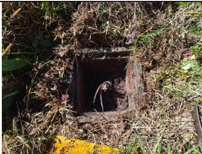
Fig. N° 16 UBICADO EN LA PARTE LATERAL IZQUIERDO, POSTERIOR, DE FORMA CUADRADA MATERIAL DE CEMENTO. DETERIORADA (pozo a intervenir).
