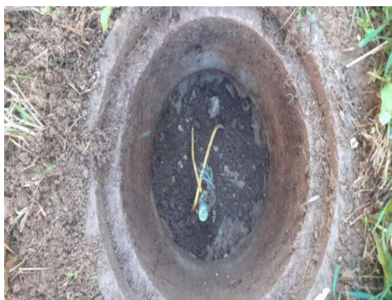
Fig. N° 29 UBICADO EN LA PARTE POSTERIOR, COSTADO DERECHO, PRESENTA CAJA DE CONCENTRO SIN PINTAR. (pozo a intervenir).
