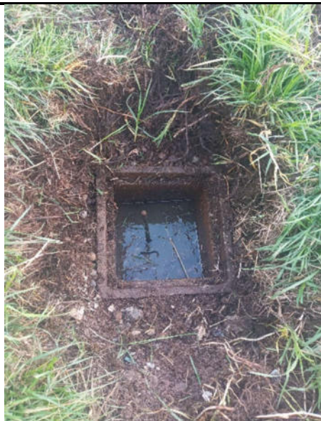
Fig. N° 25 POZO A SER REEMPLAZADO, UBICAR UN LUGAR CERCANO A 5 METROS PARA REALIZAR EL NUEVO POZO A TIERRA
