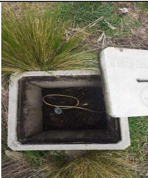
Fig. N° 21 UBICADO EN LA PARTE POSTERIOR, COSTADO DERECHO, PRESENTA CAJA DE CONCRETO CON TAPA, SIN PINTAR Y PRESENCIA DE OXIDOS. (pozo a intervenir).
