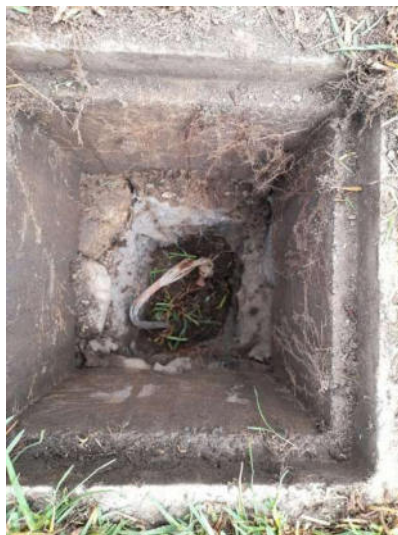
Fig. N° 13 UBICADO EN LA PARTE FRONTAL, COSTADO DERECHO, CON CAJA DE CONCENTRO. PRESENTA CABLE DE COBRE OXIDADO DETERIORADO (pozo a intervenir)
