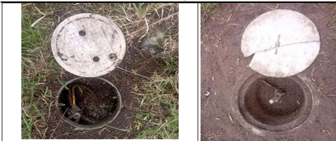
Fig. N° 23 POZOS PARA CAMBIO DE CONECTOR Y LIMPIEZA.
