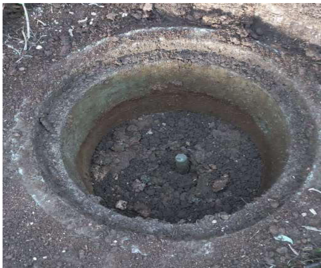
Fig. N° 11 UBICADO EN EL COSTADO IZQUIERDO, PRESENTA CAJA DE CONCENTRO SIN PINTAR MAL INSTALADO CON TAPA DE CEMENTO RAJADO. (pozo a intervenir)
