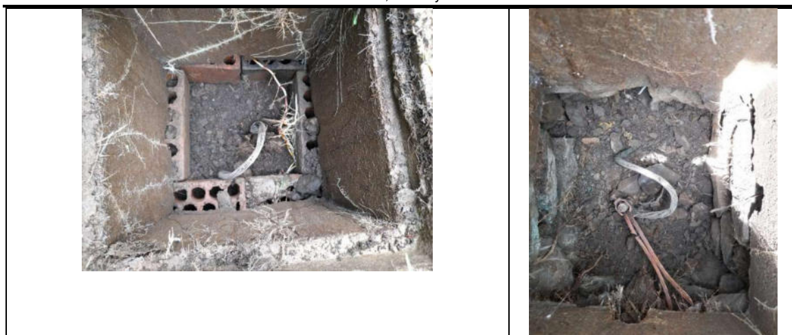
Fig. N° 14 POZOS UBICADOS ALREDEDOR DEL TAMBO, PARA EL CAMBIO DE CONECTOR Y TAPA
