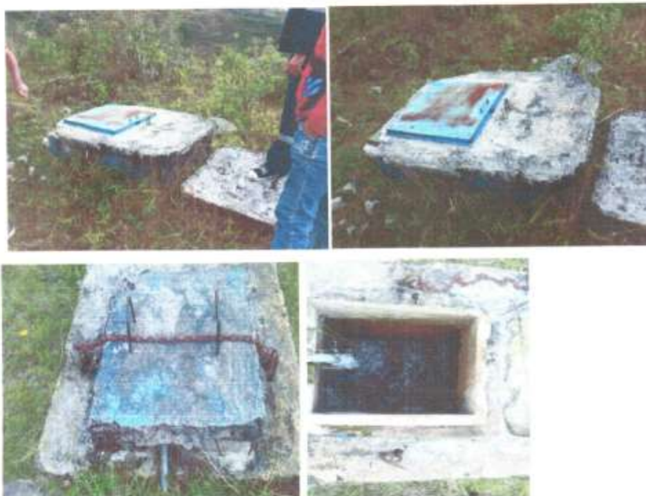
Estado de las CRP en la Línea de conducción y distribución Tunaspampa Lucmaconga.
