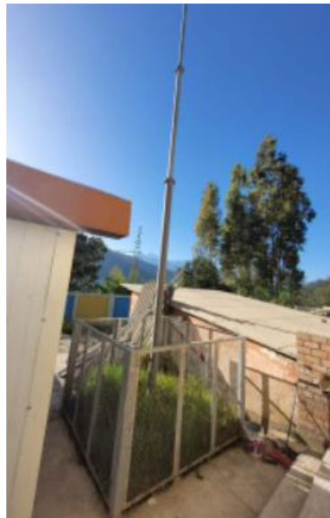
Ilustración 8. Pararrayo instalado en la I.E.
