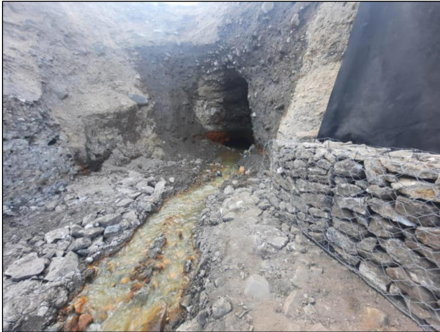
Figura 4: Bocamina ID 8766 (Sección actual 1.5 m x 2.2 m aproximadamente)
