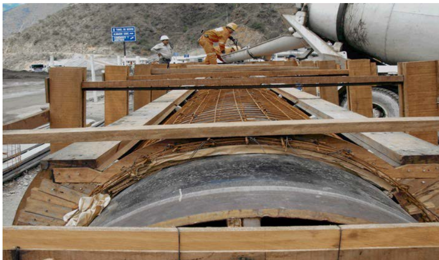
Gráfico N° 13 – Vaciado de concreto para anillo de protección.
