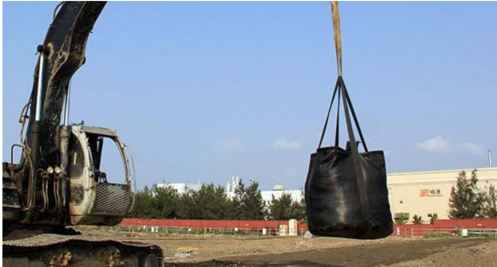
Gráfico N° 22 – Izaje de bolsa de geotextil.
