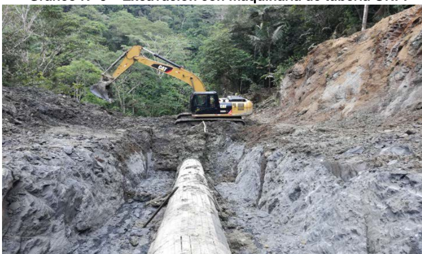
Gráfico N° 3 – Excavación con maquinaria de tubería ONP.
