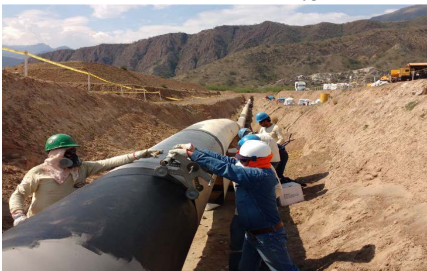
Gráfico N° 10 – Colocación de Polyguard.
