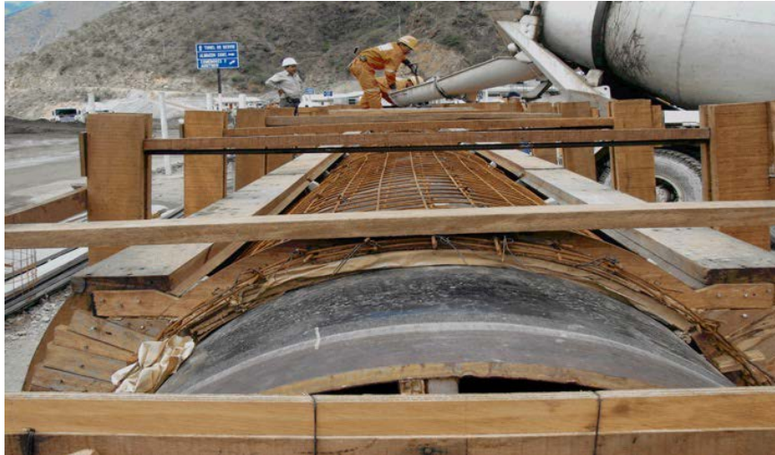
Gráfico N° 13 – Vaciado de concreto para anillo de protección.
