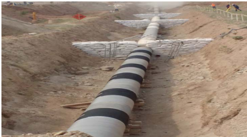
Gráfico N° 15 – Anillo de protección terminado.
