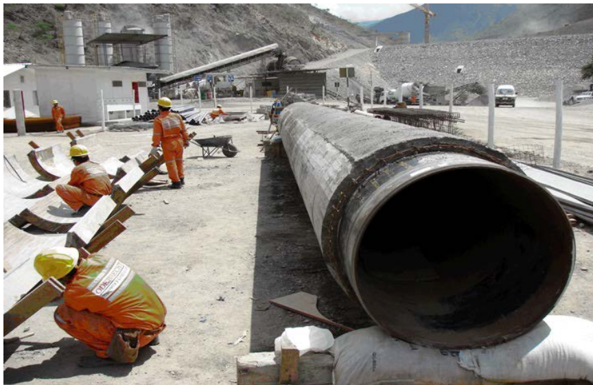
Gráfico N° 14 – Anillo de protección terminado.
