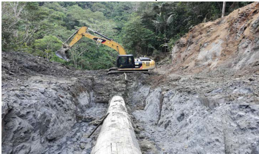
Gráfico N° 3 – Excavación con maquinaria de tubería ONP.
