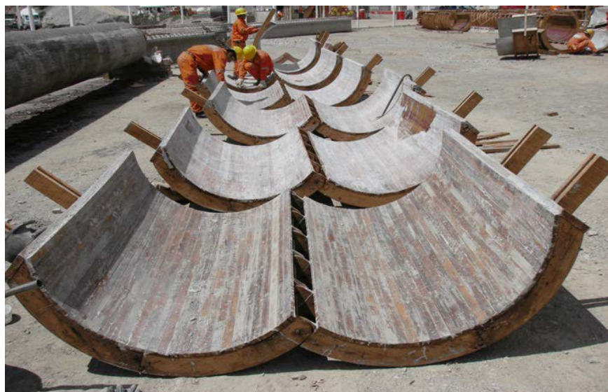
Gráfico N° 11 – Moldes de encofrado curvo.
