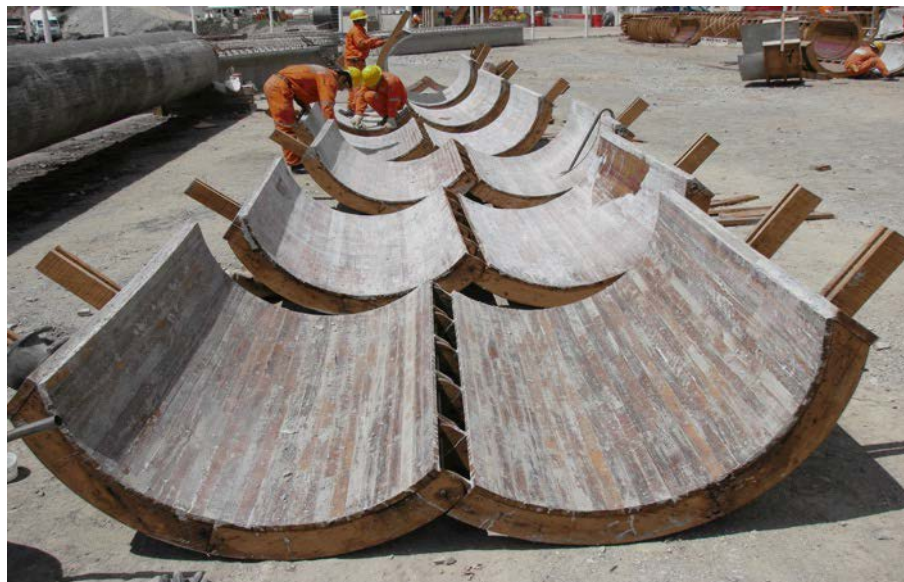
Gráfico N° 11 – Moldes de encofrado curvo.
