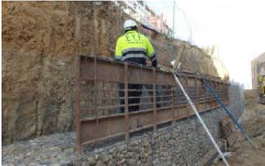
Gráfico N° 8 – Esquema del Encofrado Exterior del Gavión.
