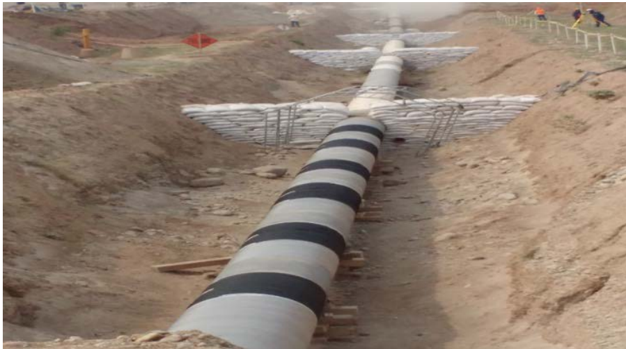
Gráfico N° 15 – Anillo de protección terminado.
