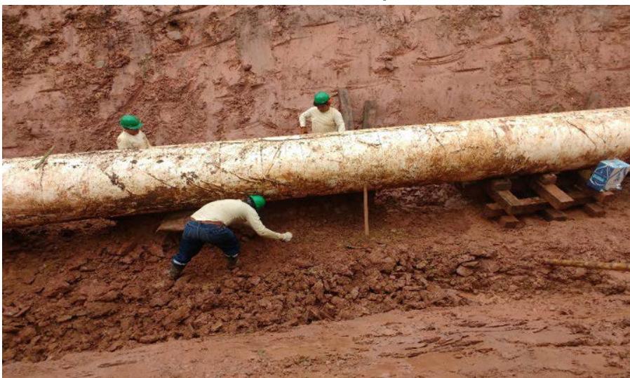
Gráfico N° 5 – Excavación manual para liberar la tubería.
