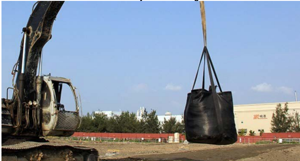
Gráfico N° 21 – Izaje de bolsa de geotextil.
