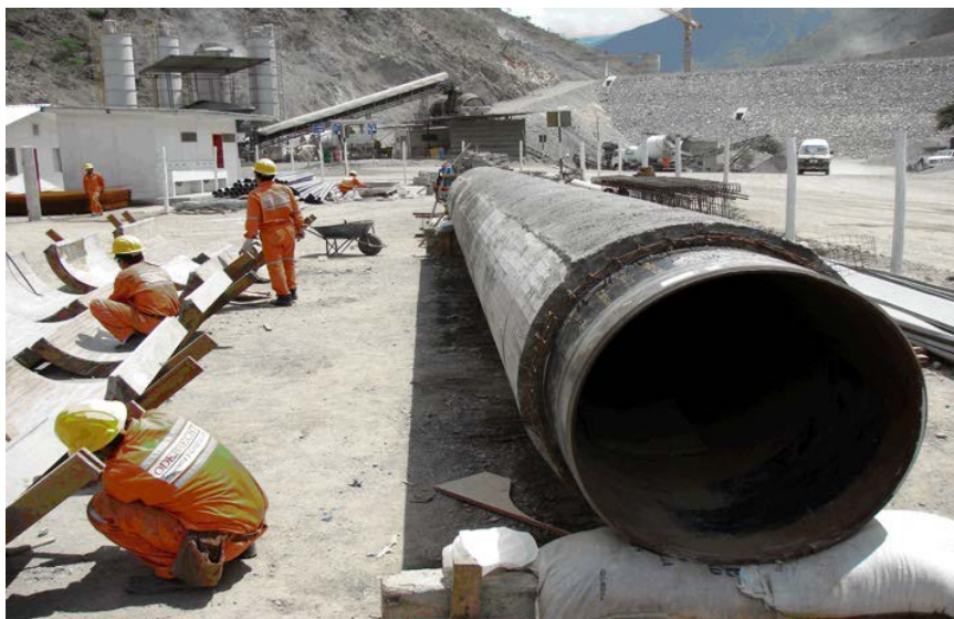
Gráfico N° 14 – Anillo de protección terminado.
