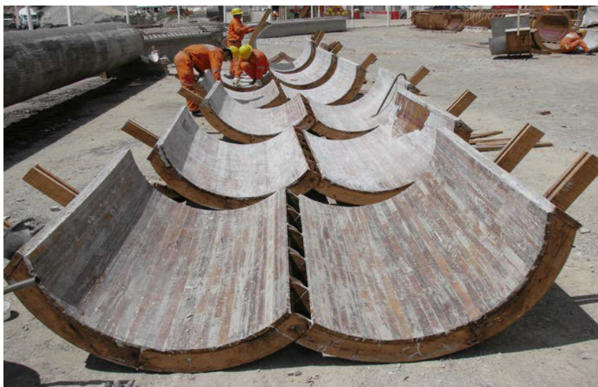
Gráfico N° 11 – Moldes de encofrado curvo.
