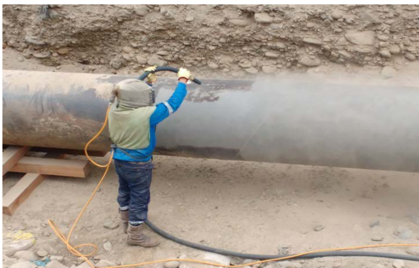
Gráfico N° 9 – Proceso de Arenado a Metal Blanco.
