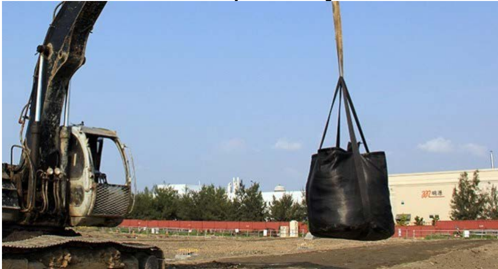
Gráfico N° 20 – Izaje de bolsa de geotextil.
