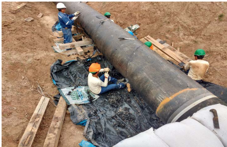
Gráfico N° 7 – Retiro de Poliken, actividad previa a la limpieza mecánica.
