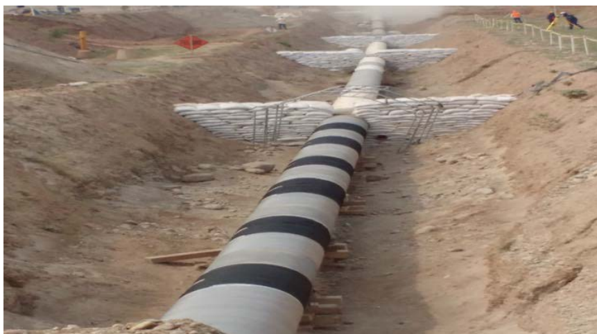
Gráfico N° 15 – Anillo de protección terminado.
