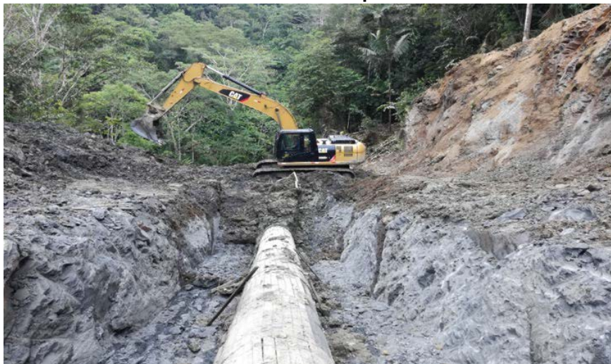
Gráfico N° 3 – Excavación con maquinaria de tubería ONP.
