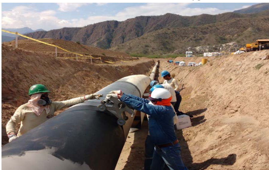
Gráfico N° 10 – Colocación de Polyguard.
