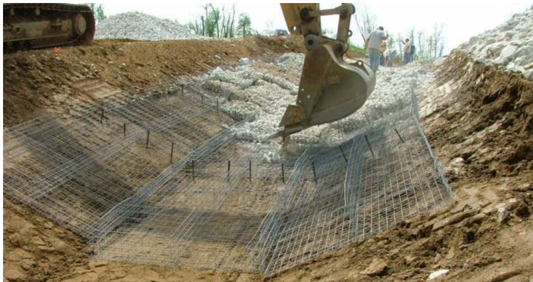
Gráfico N° 6 – Llenado de colchón reno con equipo.
