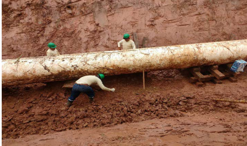
Gráfico N° 5 – Excavación manual para liberar la tubería.
