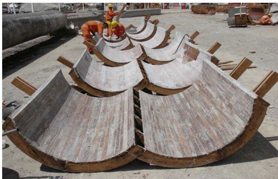
Gráfico N° 11 – Moldes de encofrado curvo.
