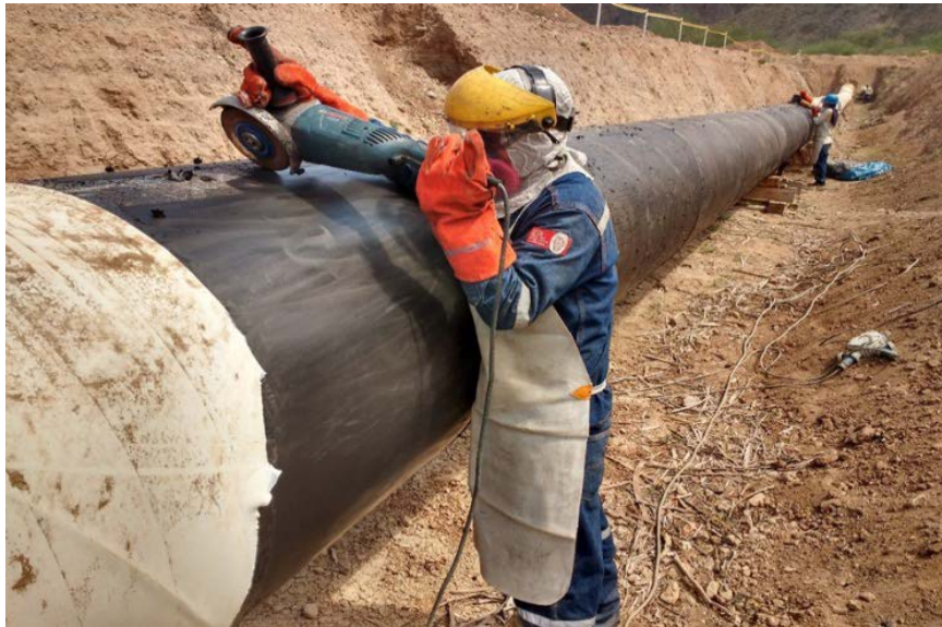
Gráfico N° 8 – Limpieza mecánica con amoladora, del ONP.
