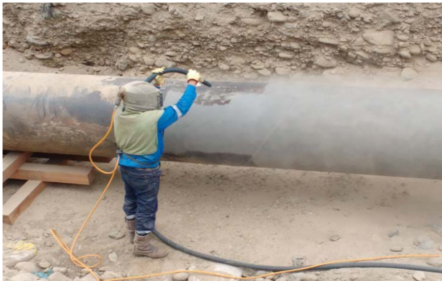
Gráfico N° 9 – Proceso de Arenado a Metal Blanco.
