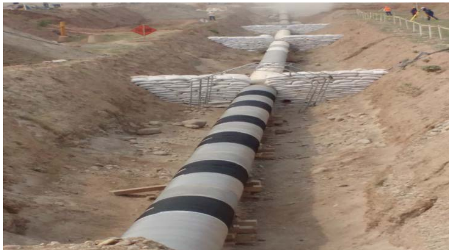
Gráfico N° 11 – Anillo de protección terminado.
