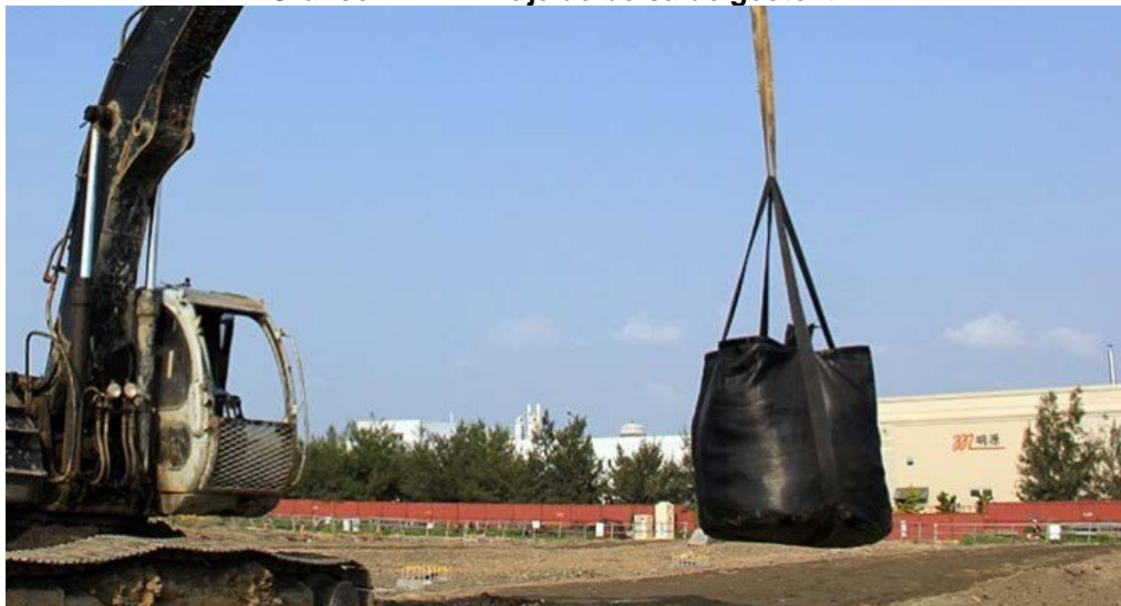
Gráfico N° 24 – Izaje de bolsa de geotextil.
