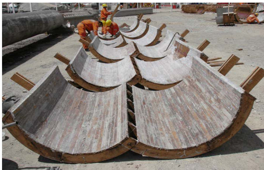
Gráfico N° 11 – Moldes de encofrado curvo.
