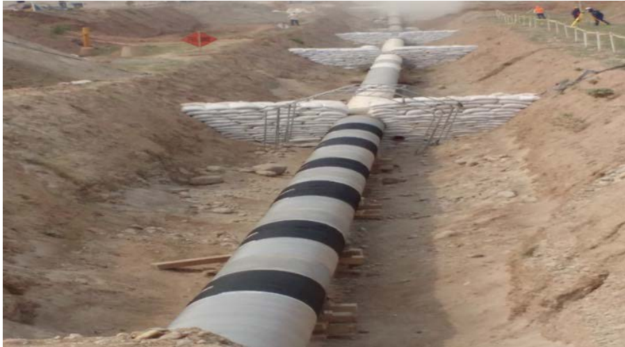
Gráfico N° 15 – Anillo de protección terminado.
