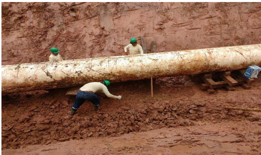
Gráfico N° 5 – Excavación manual para liberar la tubería.
