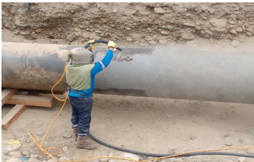
Gráfico N° 9 – Proceso de Arenado a Metal Blanco.
