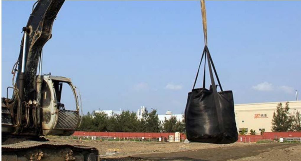
Gráfico N° 34 – Izaje de bolsa de geotextil.
