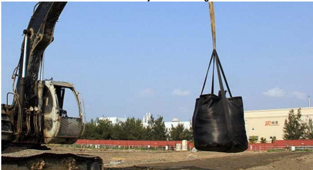
Gráfico N° 35 – Izaje de bolsa de geotextil.
