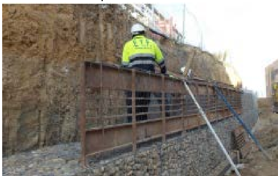
Gráfico N° 21 – Esquema del Encofrado Exterior del Gavión.
