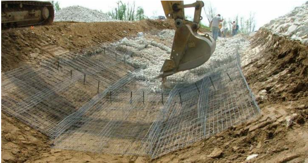
Gráfico N° 21 – Llenado de colchón reno con equipo.
