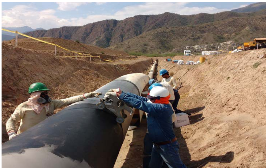
Gráfico N° 10 – Colocación de Polyguard.
