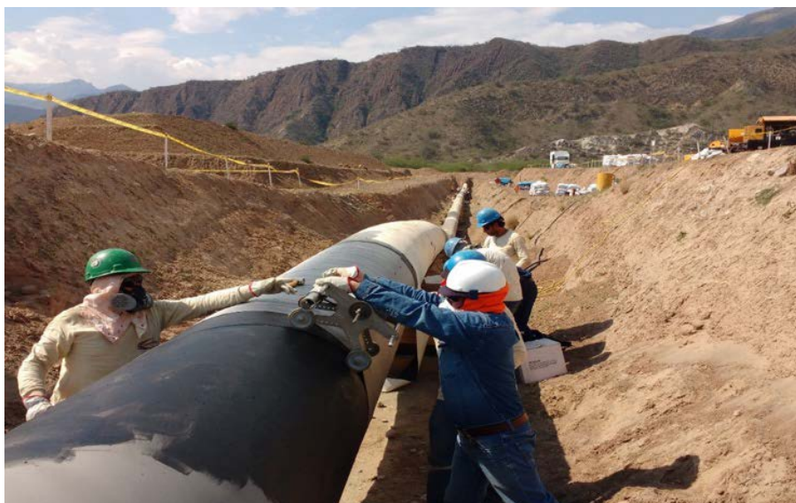
Gráfico N° 10 – Colocación de Polyguard.
