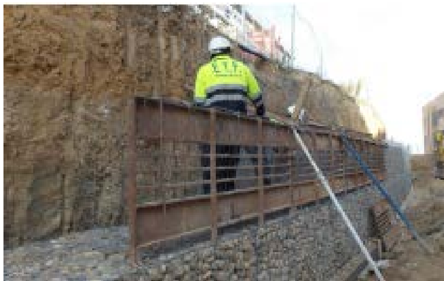
Gráfico N° 27 – Esquema del Encofrado Exterior del Gavión.
