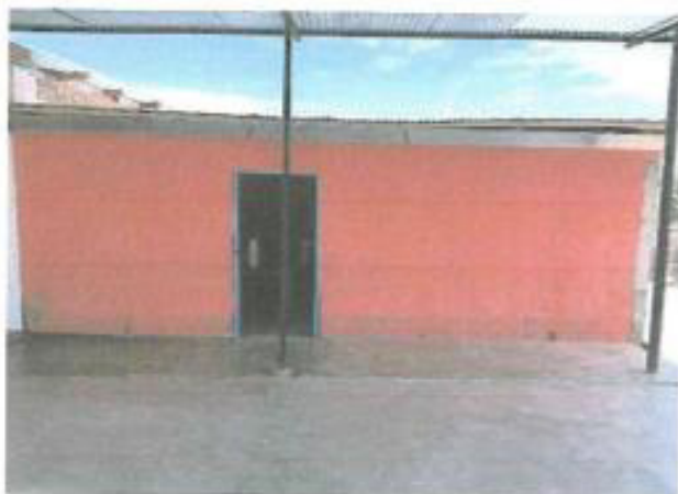
Vista Frontal de Cocina Autoconstruido en 2005 de Muros de Triplay y ladrillo en mal estado, cobertura de calamina sobre madera y piso cerámico.
