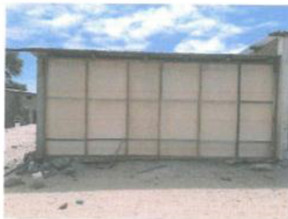
Vista posterior de cocina de muros de triplay, se observa socavamiento bajo la losa de concreto.
