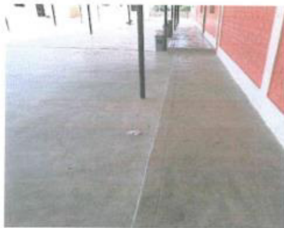
Piso de losa de patio de acabado semipulido
