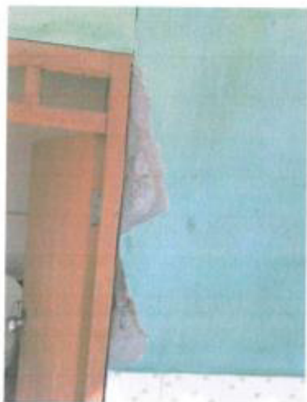
Deterioro en tarrajeo de muros de ladrillo y muro de triplay debilitado
