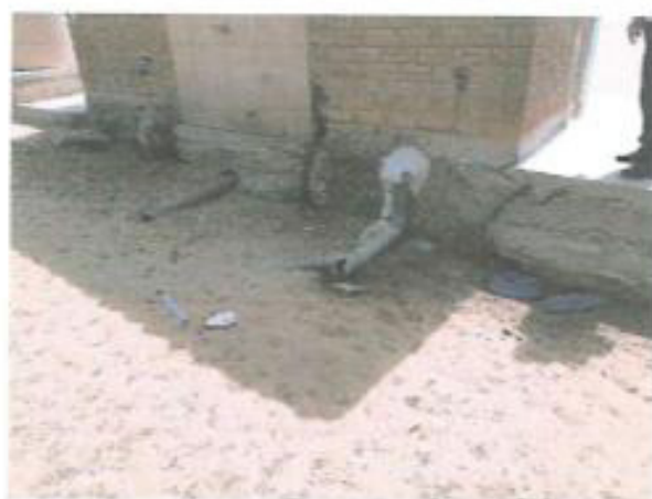
Vista Posterior de batería de SS. HH, muros de ladrillo y triplay, tubería de desagüe expuesta.
