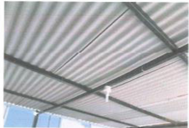
Vista de cobertura de patio de calamina sobre estructura metálica.
