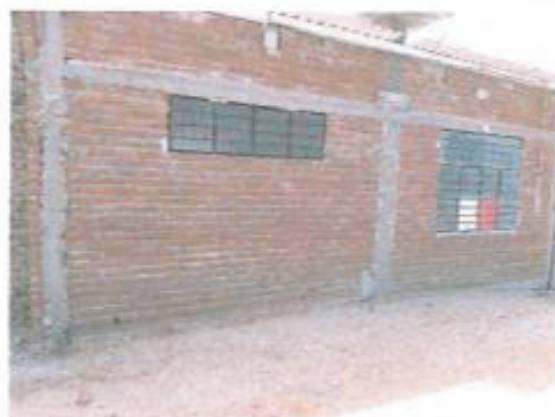
Vista posterior de pabellón autoconstruido en 1950 presenta grietas.
