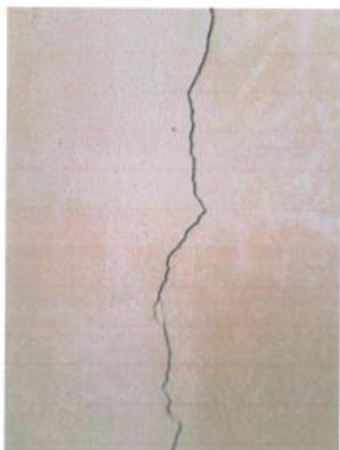
Los muros de ladrillo presentan grietas que van de lado a lado
