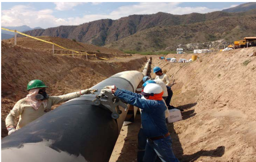
Gráfico N° 10 – Colocación de Polyguard.
