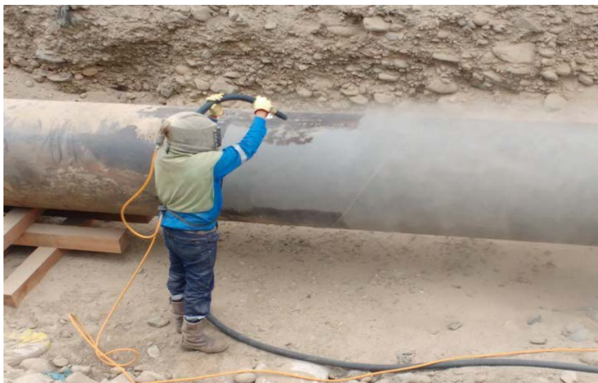
Gráfico N° 9 – Proceso de Arenado a Metal Blanco.
