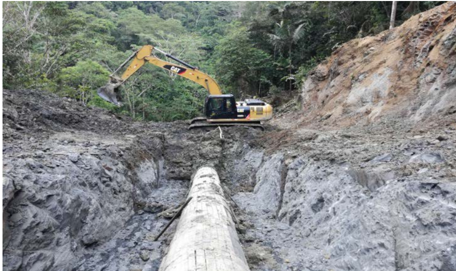
Gráfico N° 3 – Excavación con maquinaria de tubería ONP.
