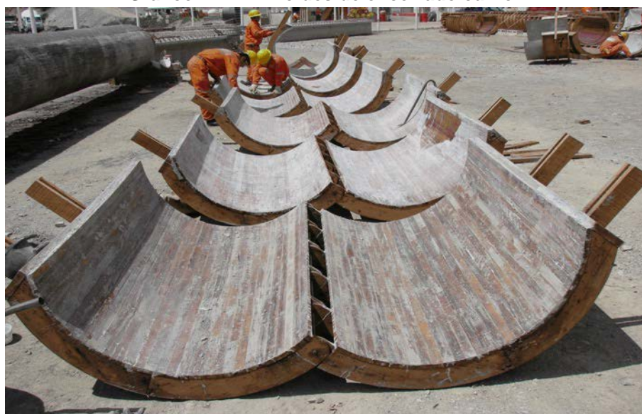
Gráfico N° 11 – Moldes de encofrado curvo.
