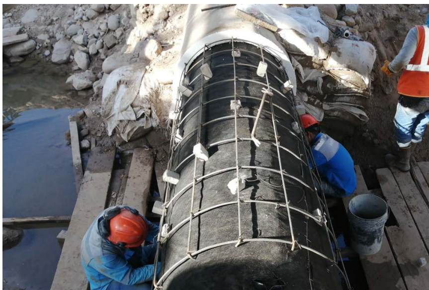
Gráfico N° 12 – Colocación de acero de refuerzo para anillo de protección.
