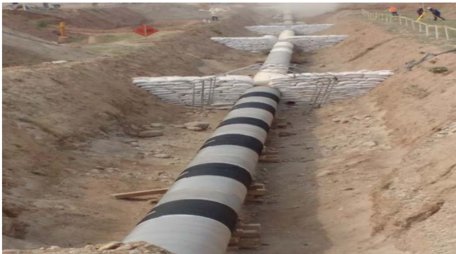
Gráfico N° 15 – Anillo de protección terminado.
