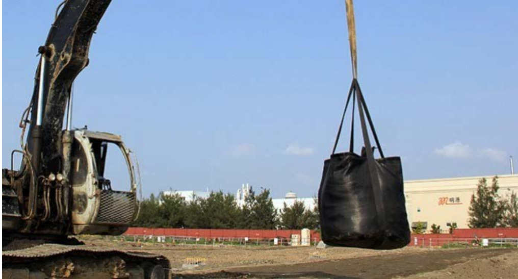
Gráfico N° 20 – Izaje de bolsa de geotextil.
