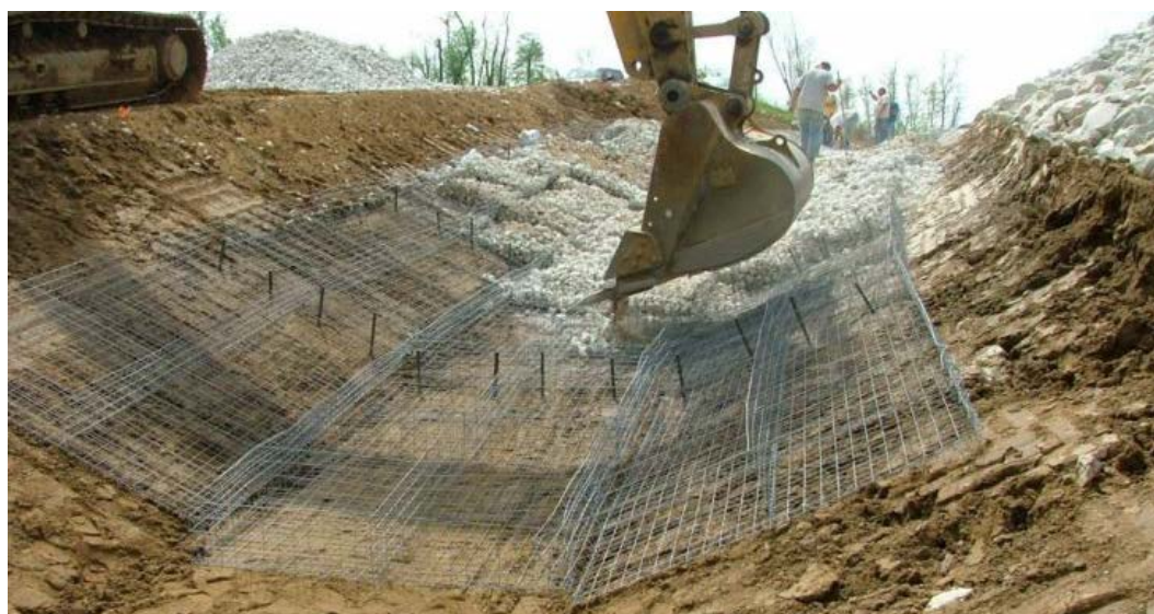
Gráfico N° 21 – Llenado de colchón reno con equipo.
