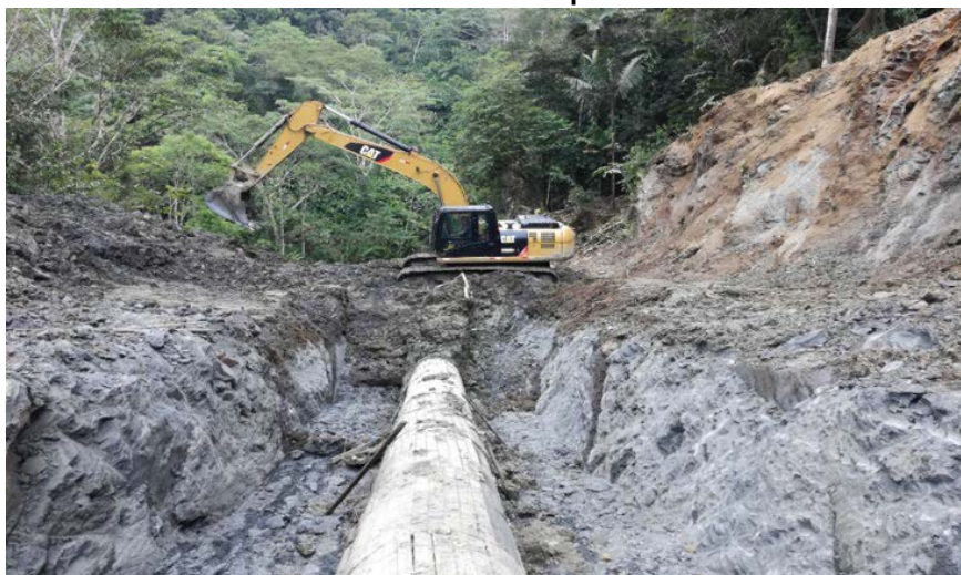
Gráfico N° 3 – Excavación con maquinaria de tubería ONP.
