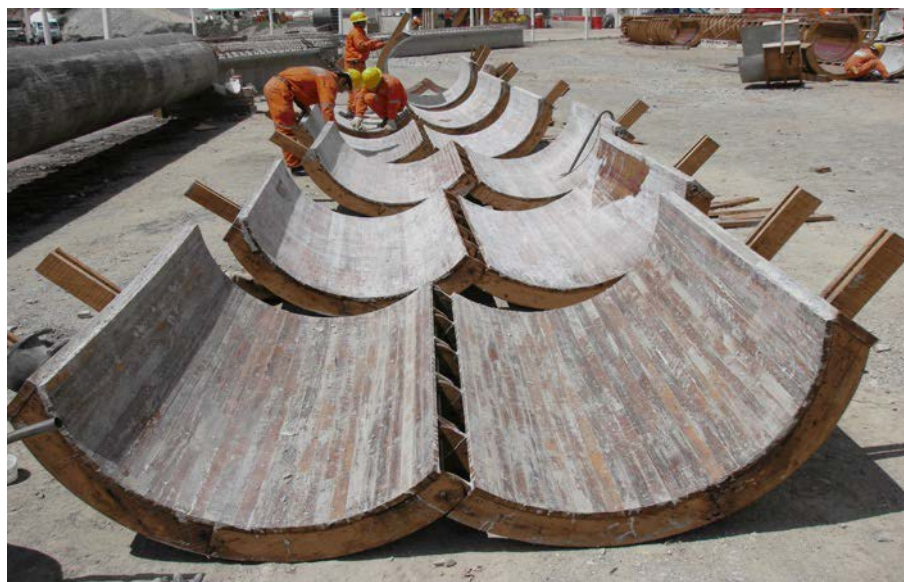
Gráfico N° 11 – Moldes de encofrado curvo.
