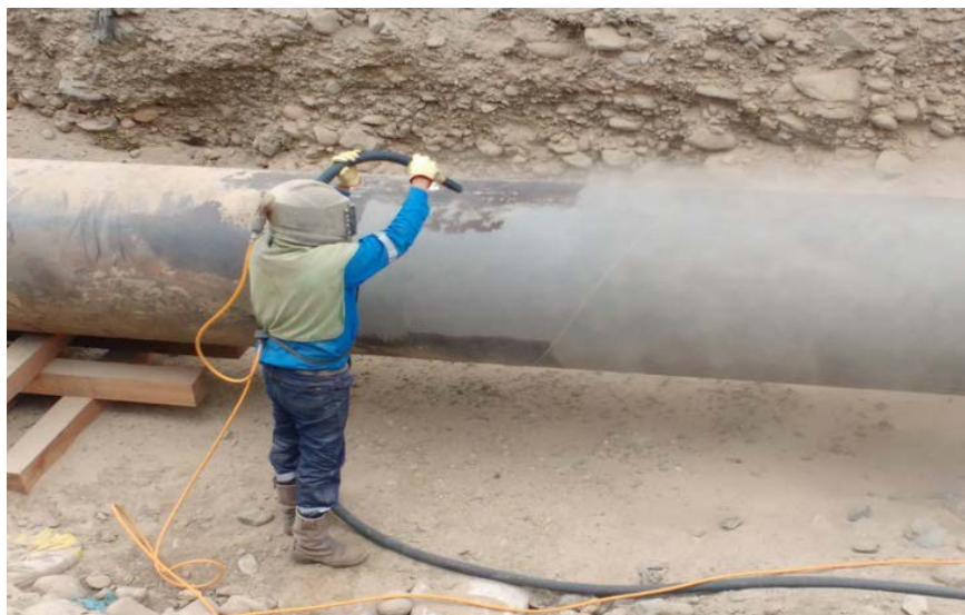
Gráfico N° 9 – Proceso de Arenado a Metal Blanco.
