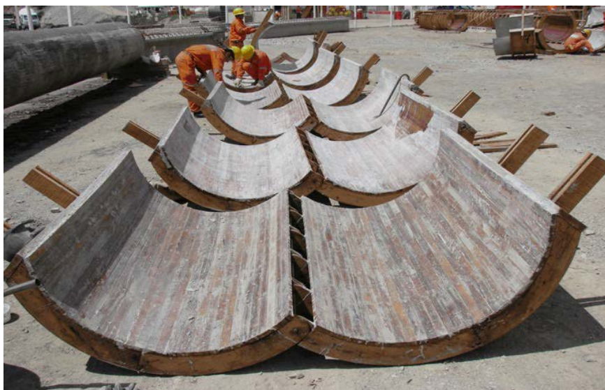
Gráfico N° 11 – Moldes de encofrado curvo.
