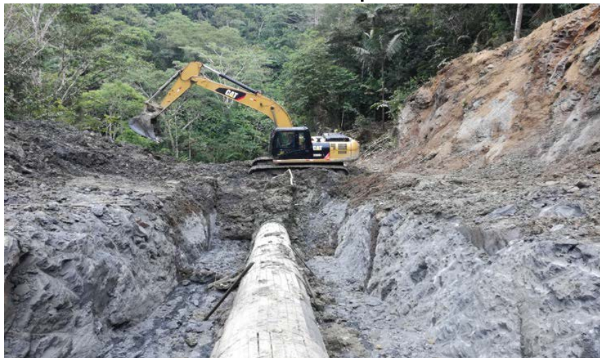
Gráfico N° 3 – Excavación con maquinaria de tubería ONP.
