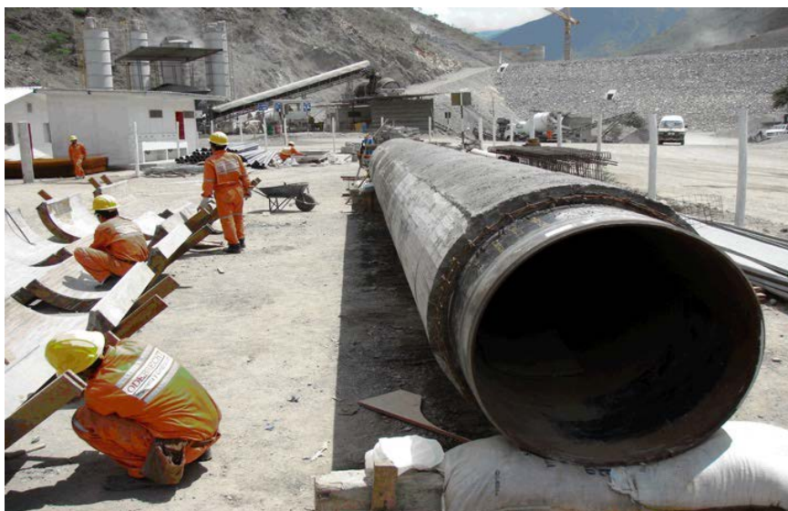
Gráfico N° 14 – Anillo de protección terminado.
