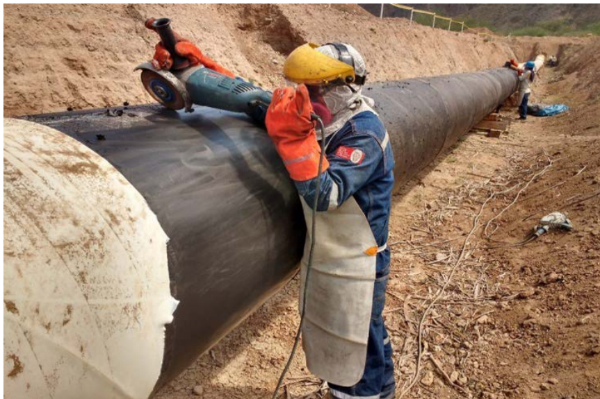
Gráfico N° 8 – Limpieza mecánica con amoladora, del ONP.
