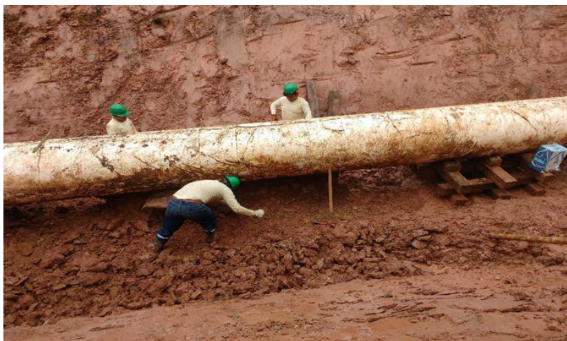
Gráfico N° 5 – Excavación manual para liberar la tubería.
