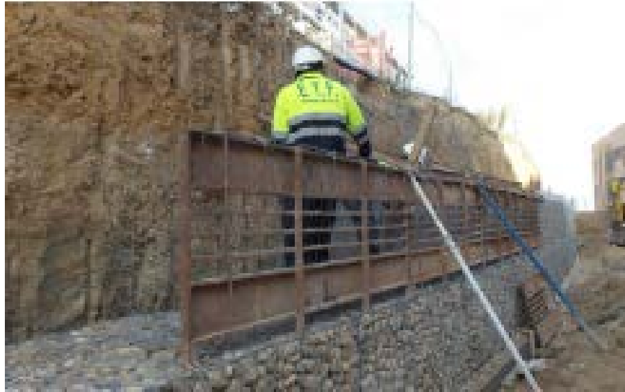
Gráfico N° 8 – Esquema del Encofrado Exterior del Gavión.
