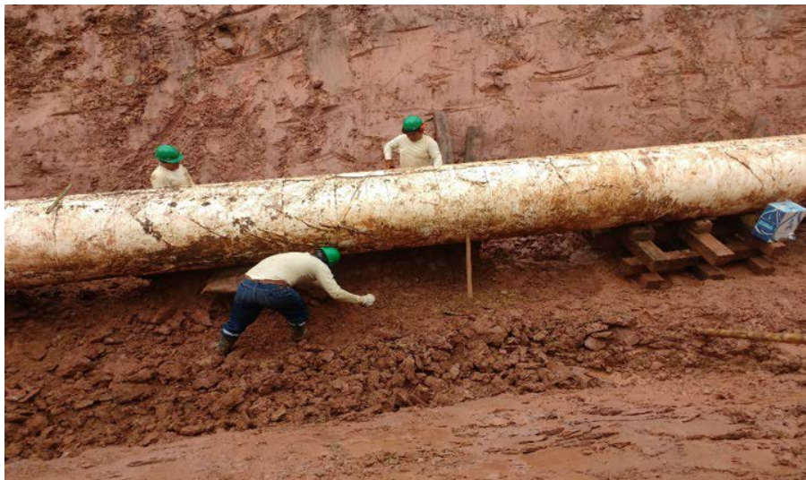
Gráfico N° 5 – Excavación manual para liberar la tubería.
