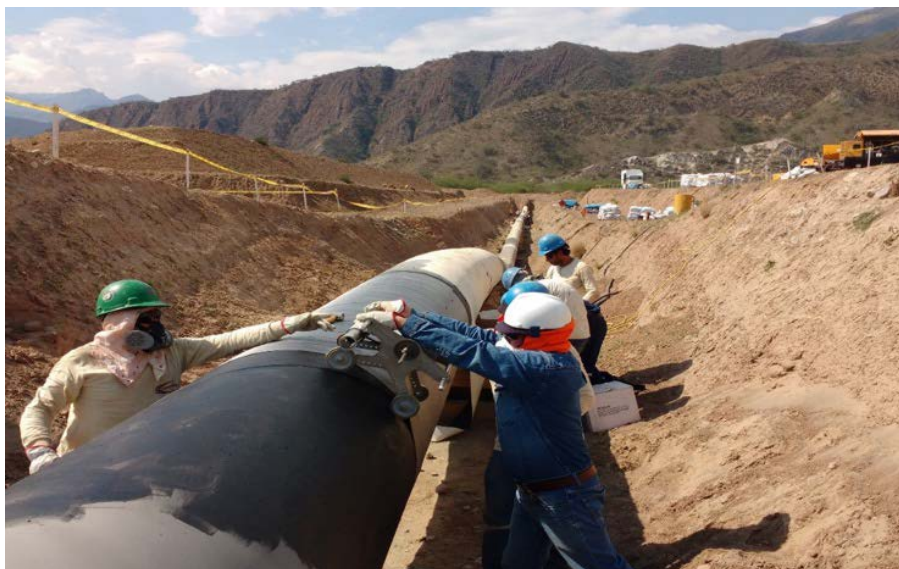
Gráfico N° 10 – Colocación de Polyguard.
