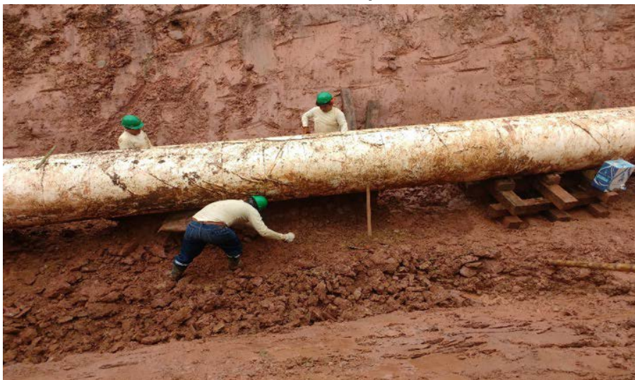
Gráfico N° 5 – Excavación manual para liberar la tubería.
