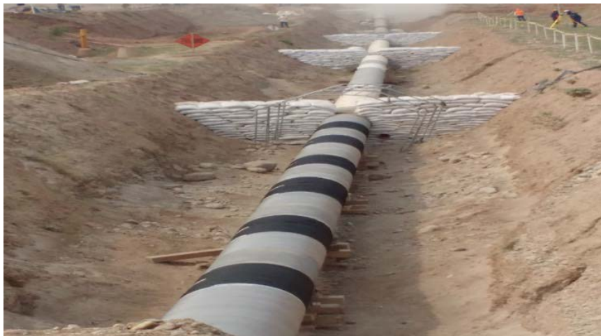
Gráfico N° 15 – Anillo de protección terminado.
