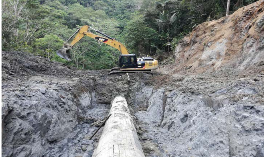
Gráfico N° 3 – Excavación con maquinaria de tubería ONP.
