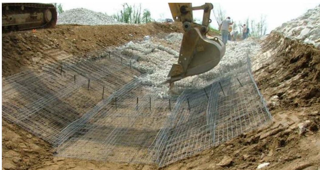
Gráfico N° 6 – Llenado de colchón reno con equipo.
