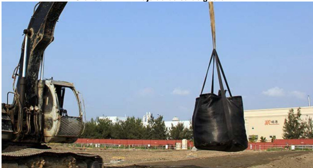
Gráfico N° 21 – Izaje de bolsa de geotextil.
