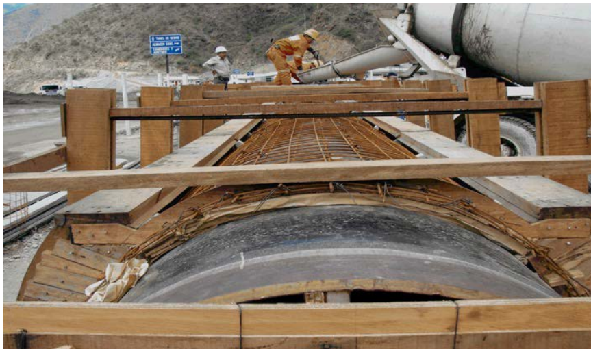
Gráfico N° 13 – Vaciado de concreto para anillo de protección.
