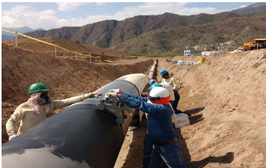
Gráfico N° 10 – Colocación de Polyguard.
