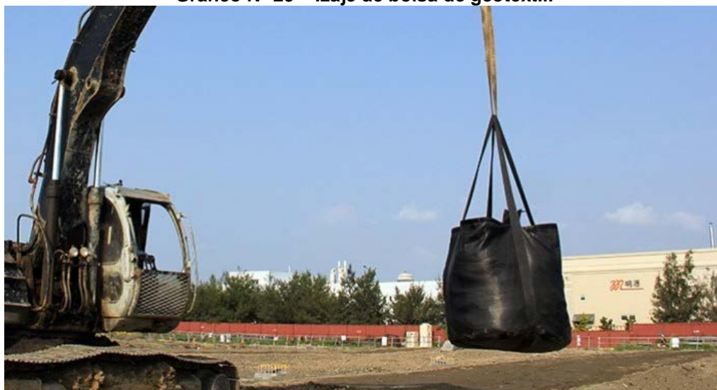
Gráfico N° 25 – Izaje de bolsa de geotextil.
