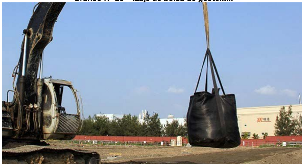
Gráfico N° 25 – Izaje de bolsa de geotextil.
