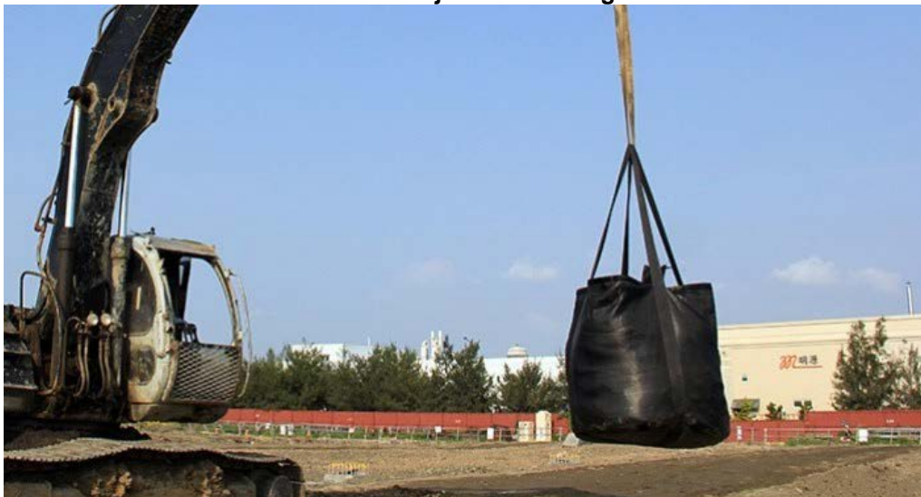
Gráfico N° 35 – Izaje de bolsa de geotextil.
