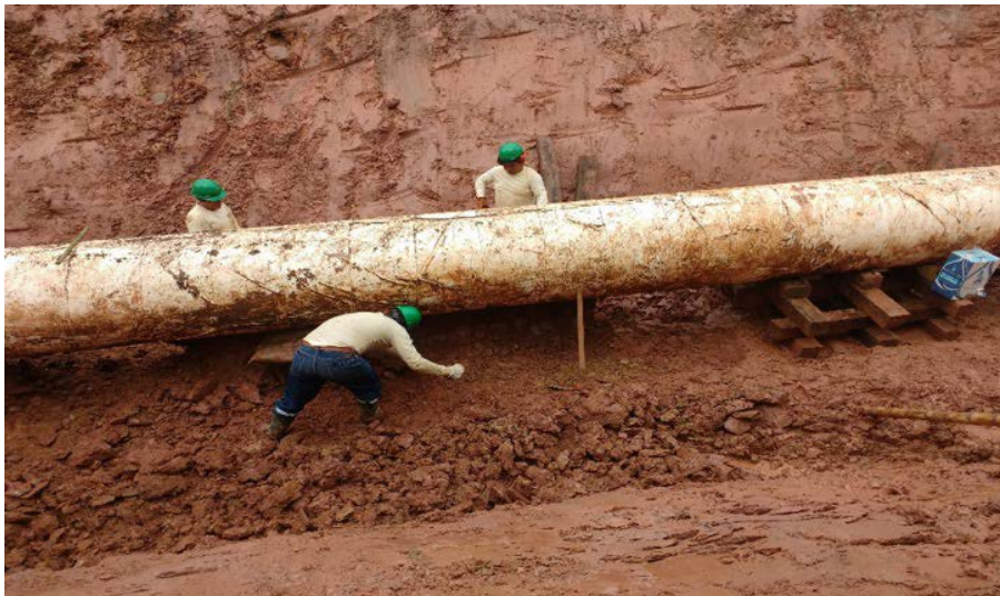
Gráfico N° 5 – Excavación manual para liberar la tubería.
