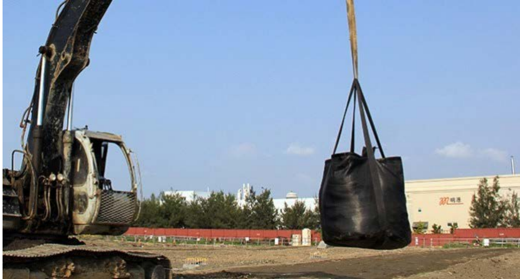
Gráfico N° 36 – Izaje de bolsa de geotextil.
