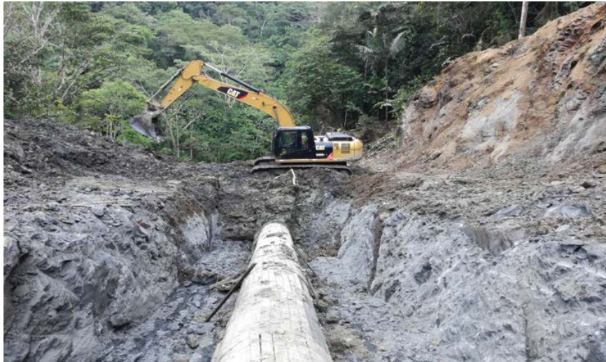
Gráfico N° 3 – Excavación con maquinaria de tubería ONP.
