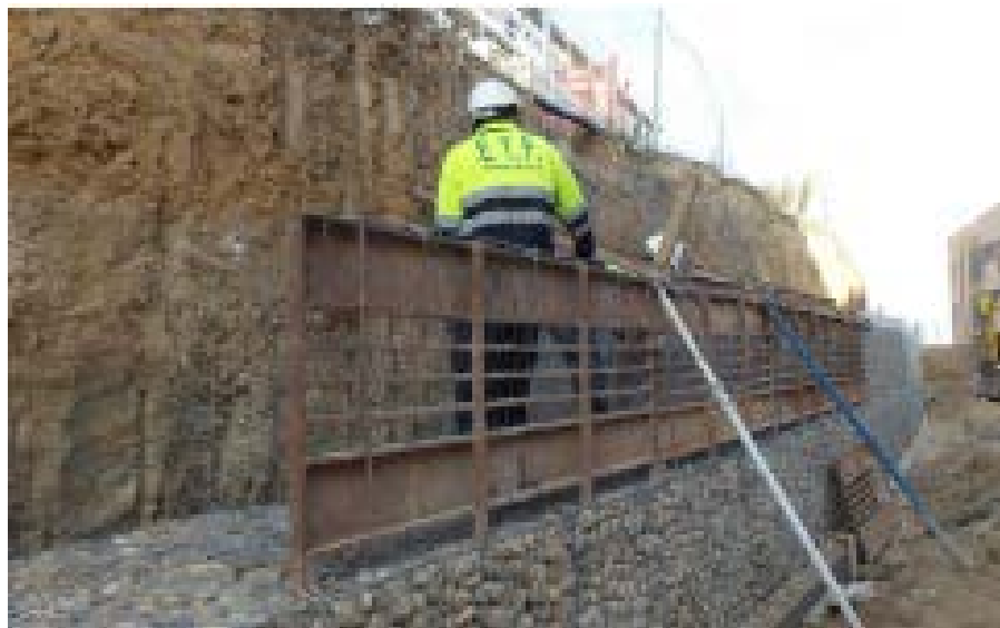
Gráfico N° 21 – Esquema del Encofrado Exterior del Gavión.
