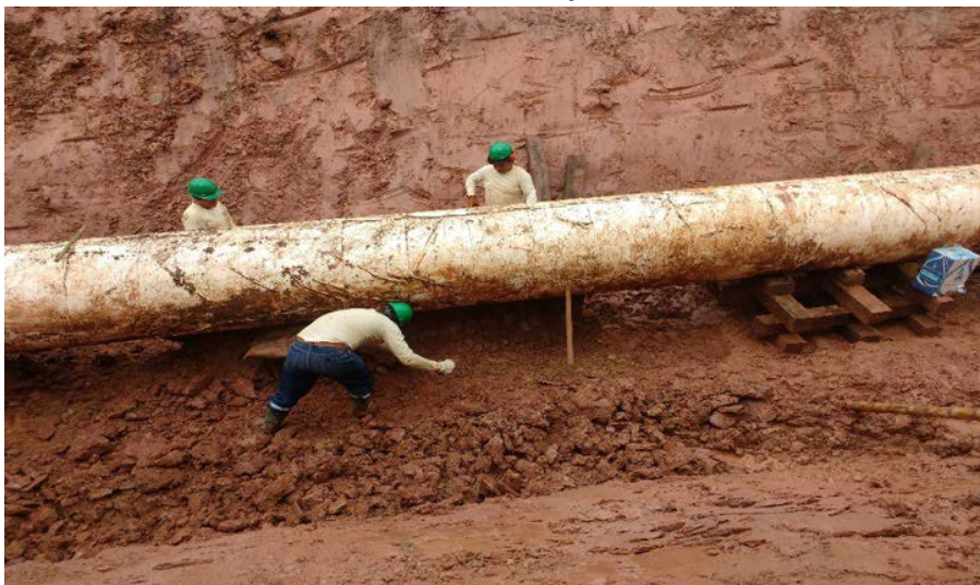
Gráfico N° 5 – Excavación manual para liberar la tubería.
