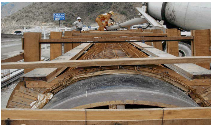
Gráfico N° 13 – Vaciado de concreto para anillo de protección.
