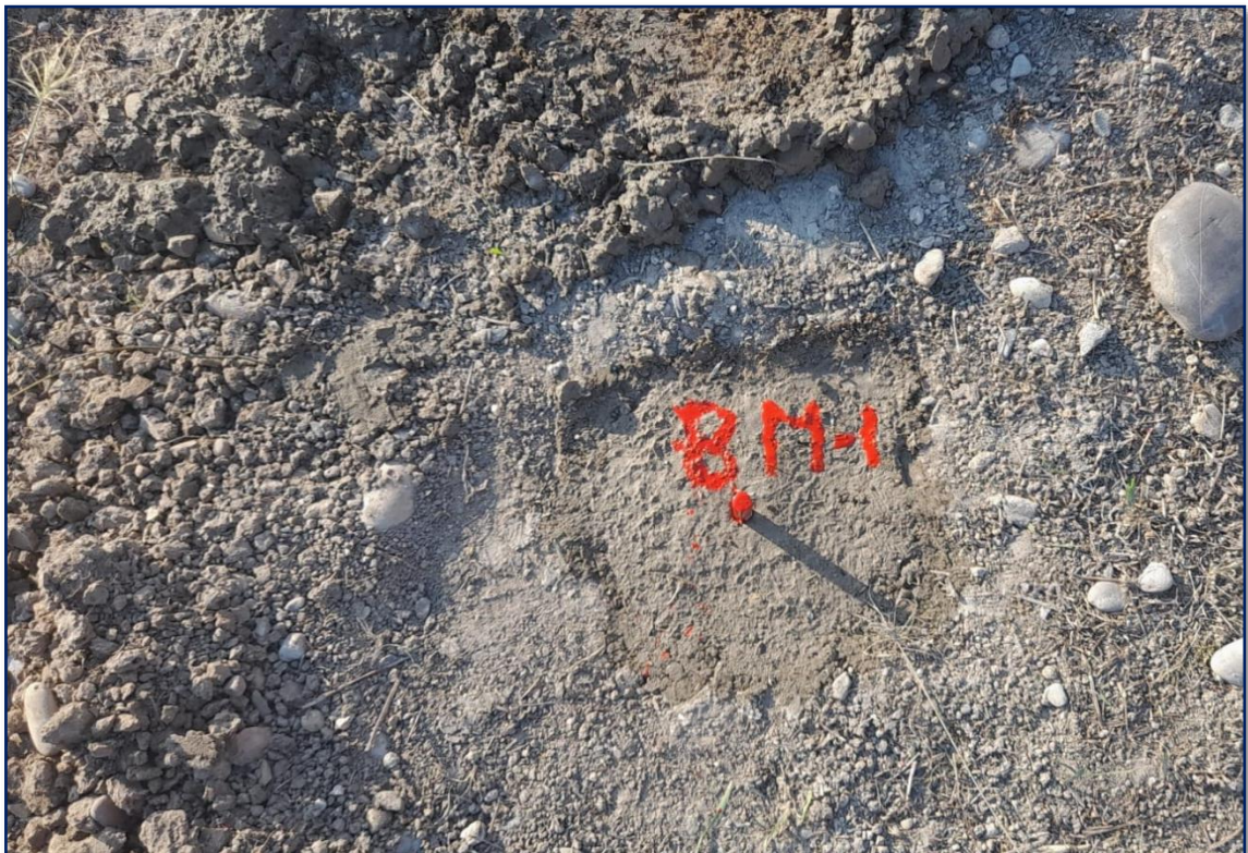
Foto de Colocación de BMs
