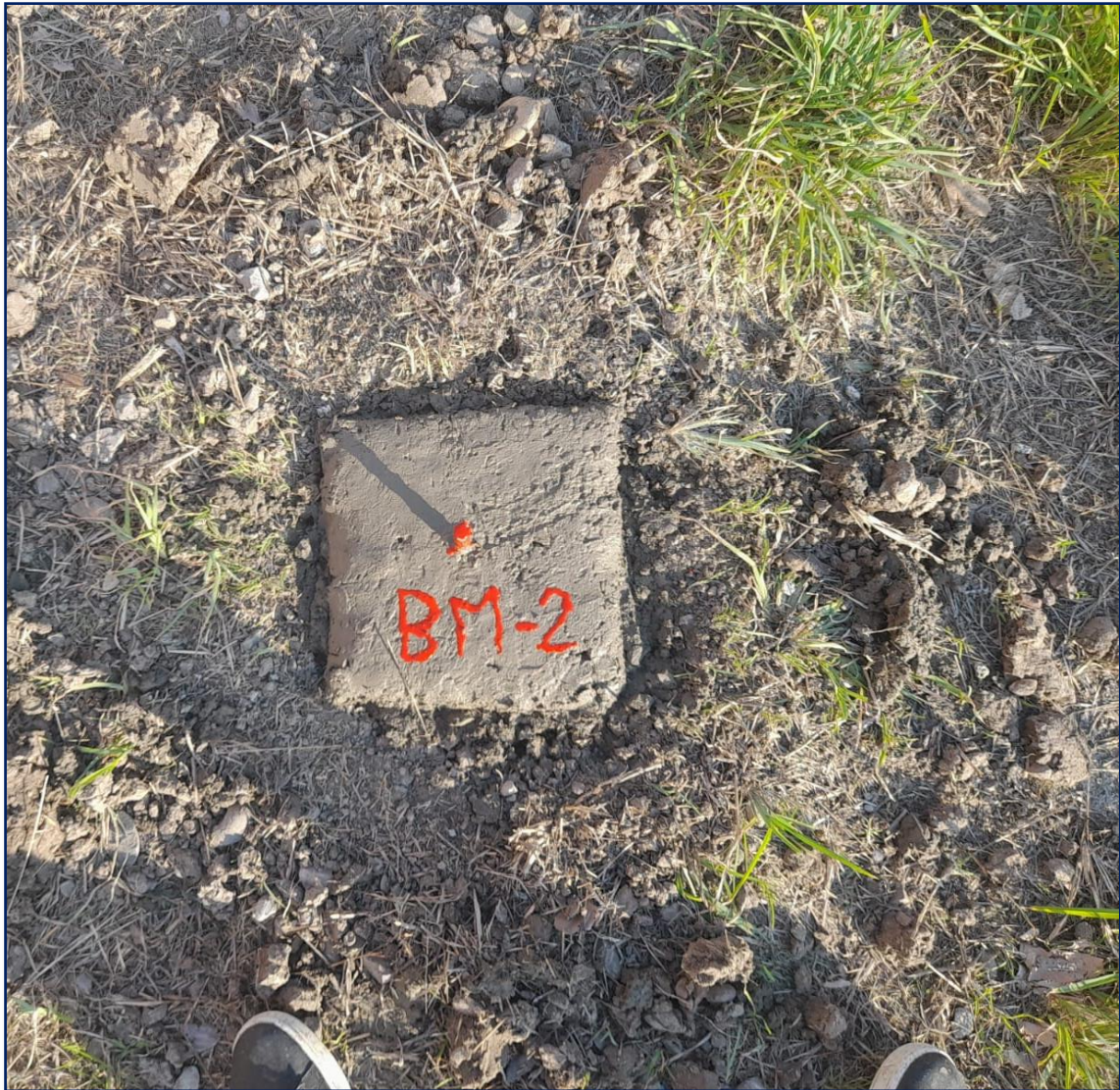
Foto de Colocación de BMs
