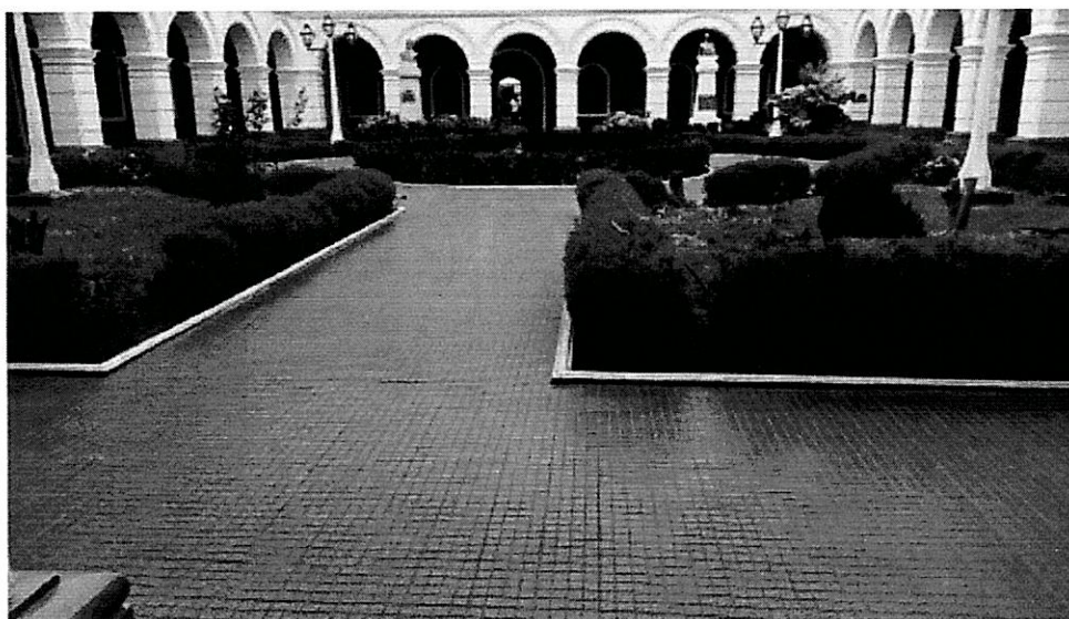
Acabado del piso de loseta roja existente de 20cm x 20cm y sardineles blancos en el patio exterior de la Sede Judicial de Pizarro.
