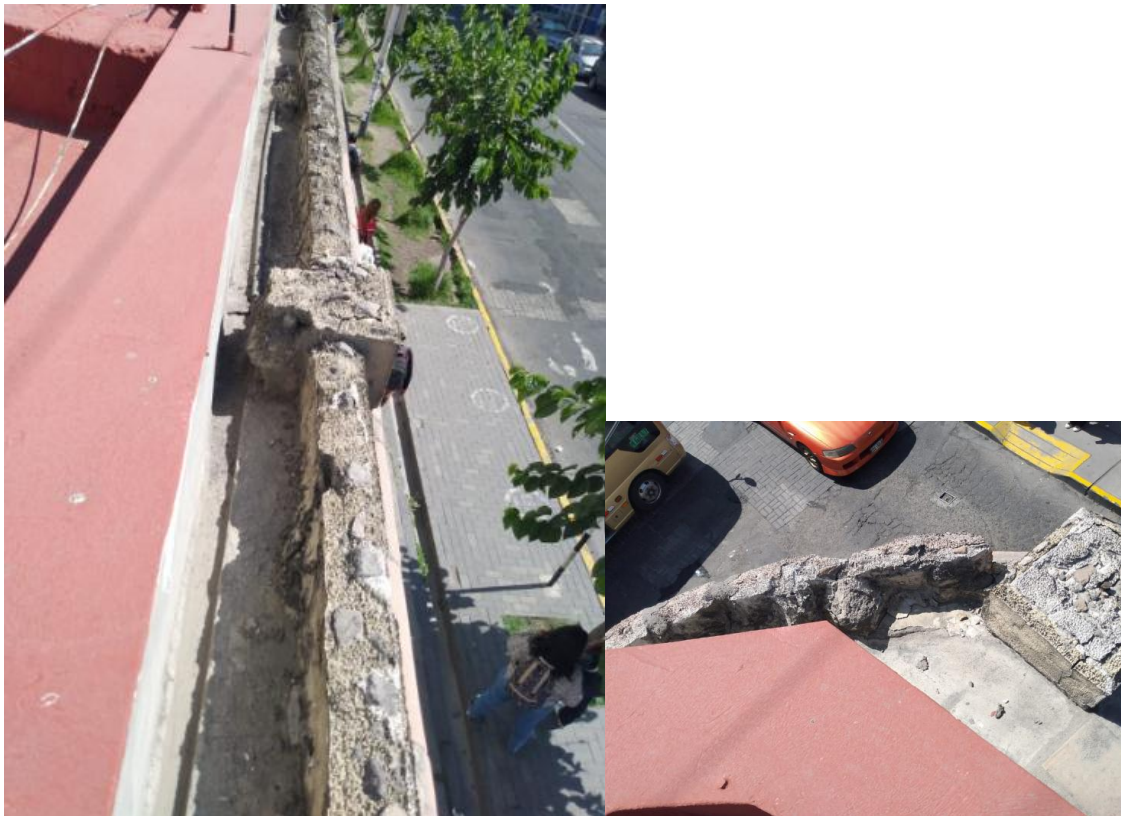
Cornisas, canales pluviales en techo, expuestos y deteriorados. Propuesta tarrajeo e impermeabilizado.
