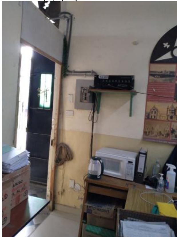
Equipo de audio voz, y tablero eléctrico existente. Se cambiara el tablero de acuerdo a los planos. Mejoramiento de voz data. Instalación de gabinete .
