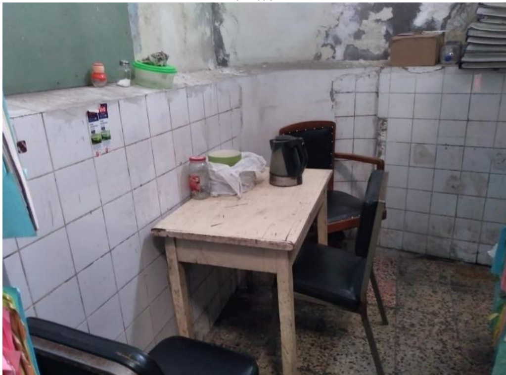
Deterioro de muro colindante a la calle, presencia de humedad. Se propone Picado de cerámico, colocación de Porcelanato a una altura de 2.40m, instalación de piso de Porcelanato
