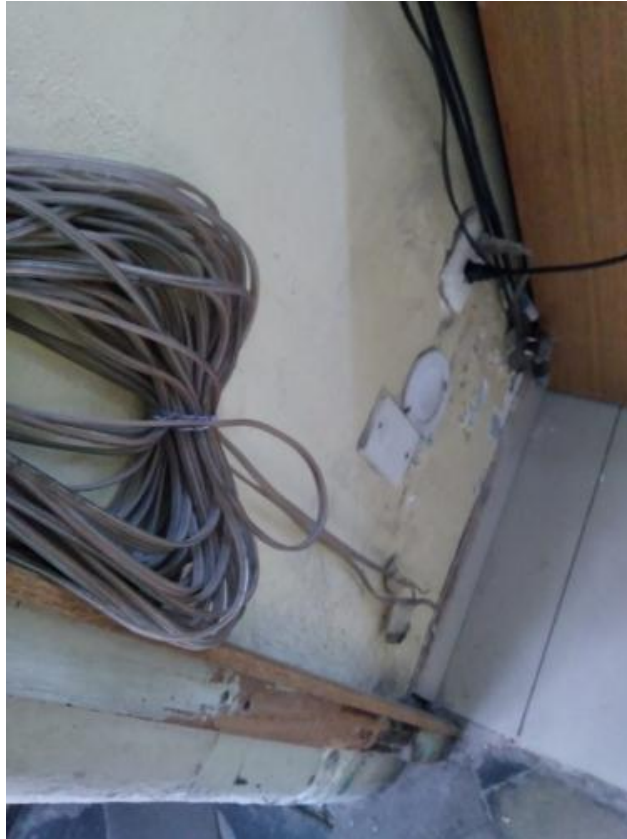
Instalaciones eléctricas y red data, mejorar cableado mediante nuevo tubería y cableado. Cambio de cajas, tapas y accesorios eléctricos.
