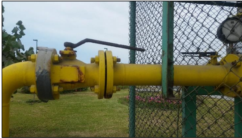
Válvula de Bloqueo de Estación de Gas
