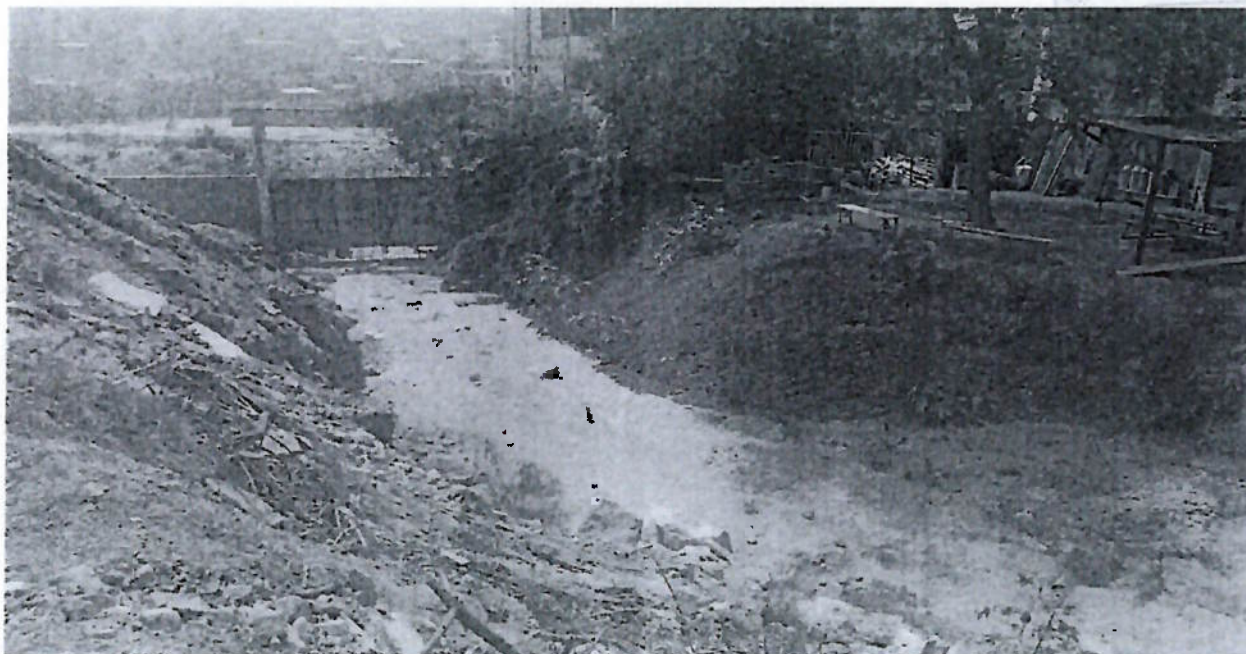
Imagen 03: Vista del cauce de la Quebrada Santo Domingo hacia aguas arriba en donde se evidencia la necesidad de muros de contención a ambos márgenes.
