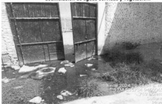
Imagen 08: Ingreso principal al Coliseo deportivo totalmente colapsado con acumulación de aguas servidas y vegetación.
