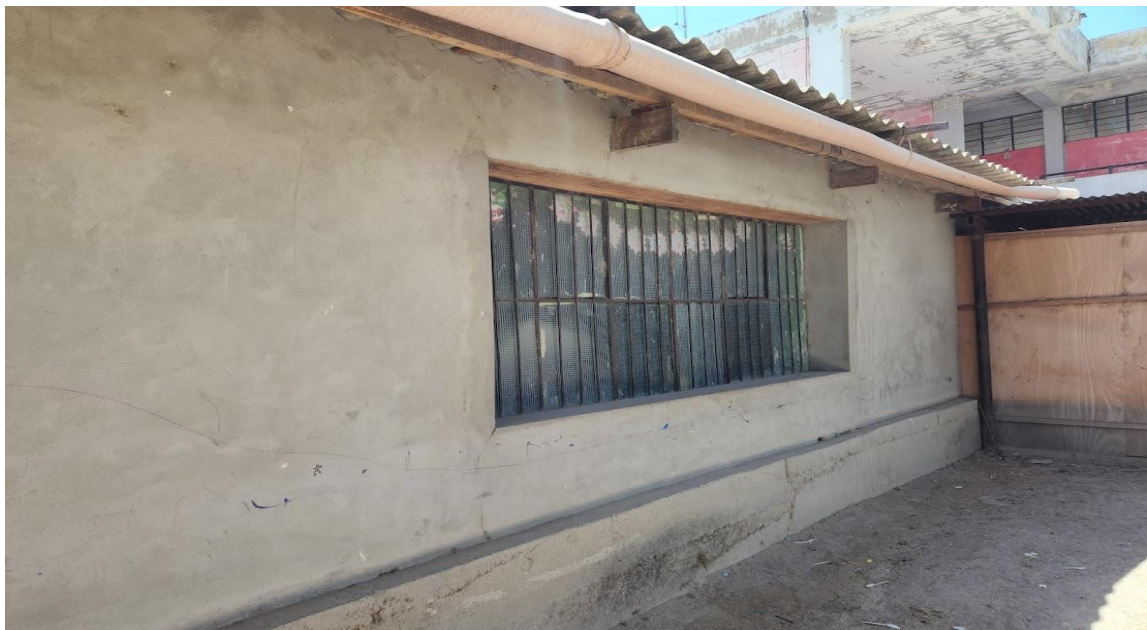
IMAGEN N° 11: se pudo apreciar la construcción de un pabellón de ambientes con material rustico de quinchá, el cual se encuentra en mal estado de conservación, presenta cobertura liviana de calamina y ventanas metálicas con vidrio.
