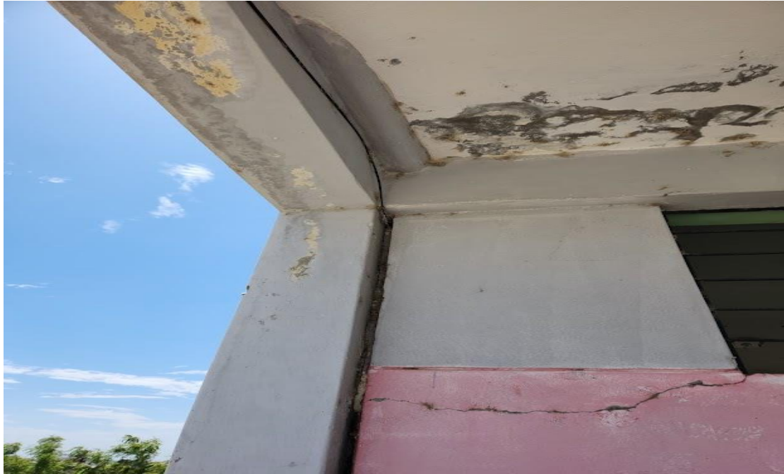
IMAGEN N° 06: durante la visita realizada, se pudo observar en diferentes zonas que los muros portantes presentan grandes agrietamientos horizontales y diagonales, esto significa un peligro estructural ya que son estos los que soportan las cargas existentes, lo cual podría ocasionar el colapso de la estructura.
