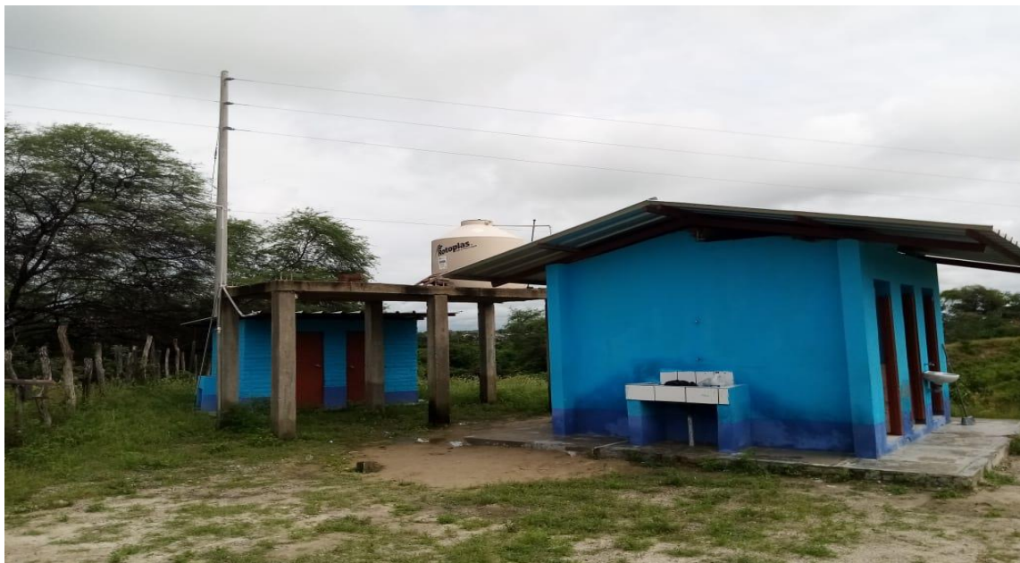
IMAGEN N° 15: se cuenta con un tanque elevado de PVC de 2500 litros de capacidad el cual está apoyado sobre una estructura de concreto de columnas y vigas. Esta estructura presenta deficiencias constructivas como fisuramientos, cangrejas t hasta exposición del acero.
