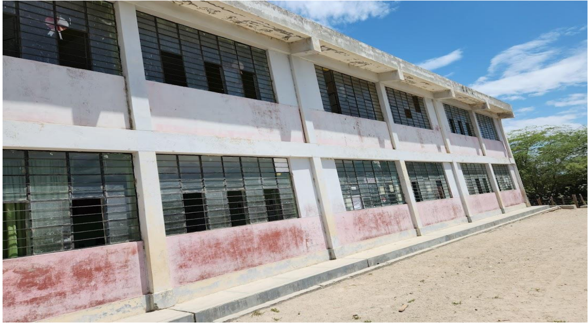
IMAGEN N° 04: se puede observar el estado actual de Institución Educativa, el cual es deficiente, la infraestructura cuenta con más de 10 años de antigüedad. La estructura presenta agrietamientos en los diferentes elementos estructurales, así como también en los muros.
