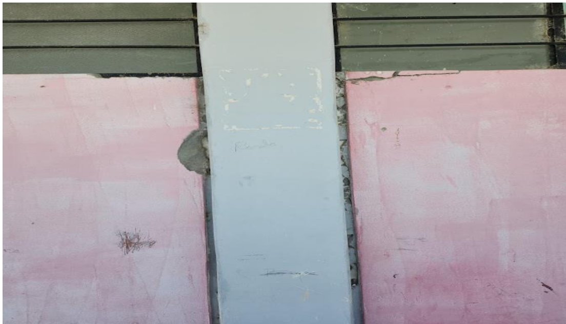
IMAGEN N° 05: se aprecia la junta de dilatación en muros portantes, la cual notoriamente se encuentra en mal estado, no cuenta con el sello asfáltico, solo se aprecia en su largo que ha sido rellenada de Tecnopor, el cual está desgastado y representa un peligro ante un evento sísmico, ya que aquí se puede producir efecto de columna corta al quedar restringido el desplazamiento lateral de esta.
