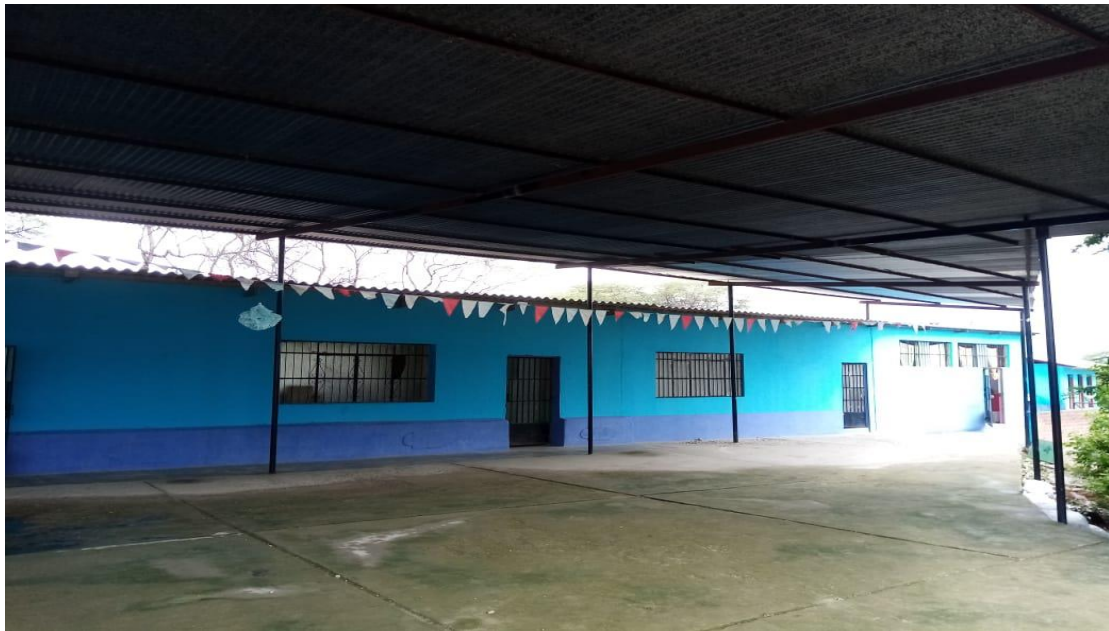
IMAGEN N° 10: El boque N° 02, está conformado por diferentes ambientes, los cuales son usados para dirección, almacén, cocina y otros, tiene más de 15 años de antigüedad, cumpliendo ya con su vida útil está construido de material noble y rustico de adobe, la cobertura es de calamina, el piso este compuesto por cemento pulido, el cual se encuentra en mal estado de conservación. Cuenta con ventanas latas y bajos de fierro con vidrio crudo. Dichos ambientes no cumplen con los parámetros de construcción de locales escolares de nivel primario según la norma de educación.
