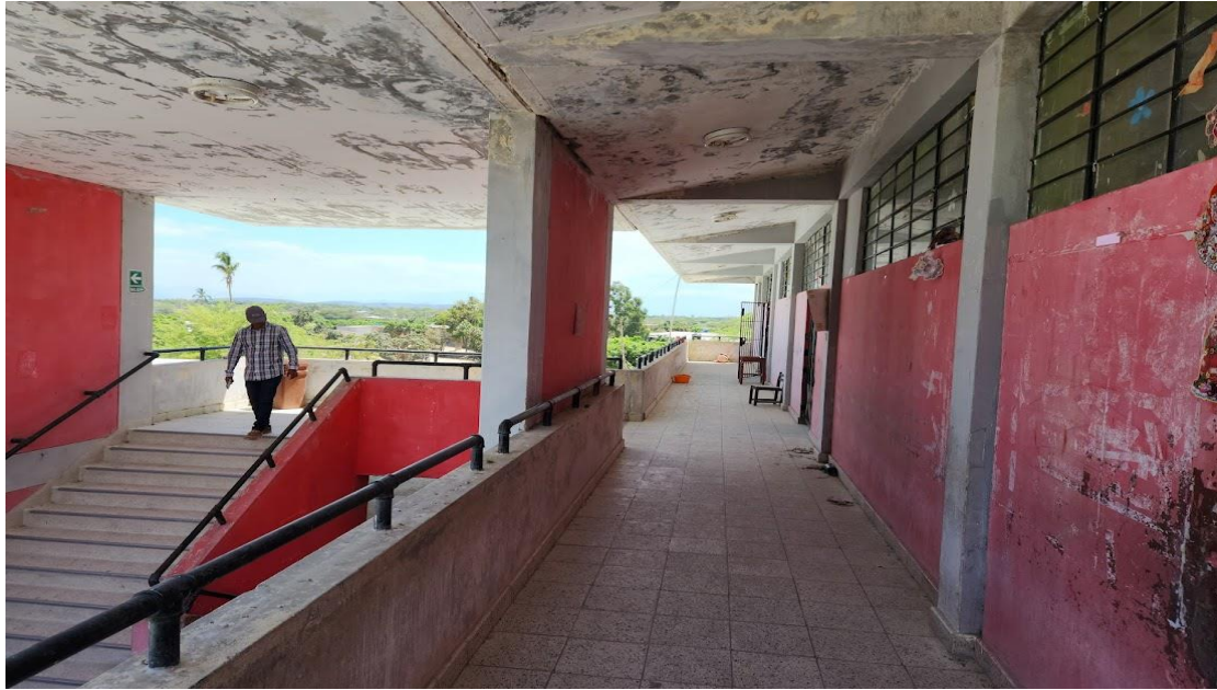
IMAGEN N° 08: se puede apreciar el deterioro y mal estado en que se encuentran las barandas de los balcones, también las ventanas presentan oxidación y los vidrios de estas están quebrados. La cobertura del techo ha sido afectada considerablemente debido a las intensas lluvias que existen en la zona. Produciendo así que haya aparición de hongos en el revestimiento de la losa.
