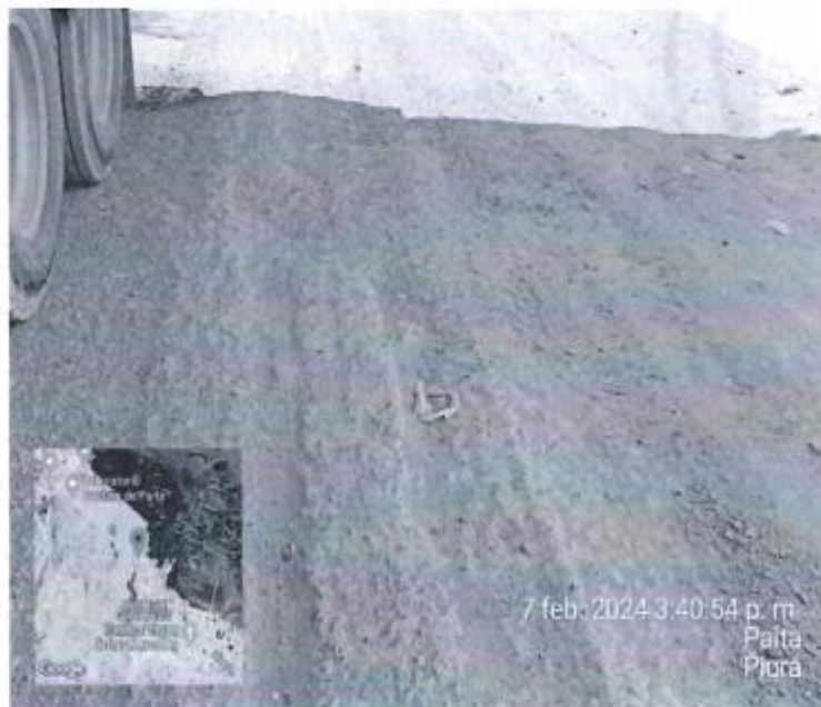
Figura 014. Pavimento Flexible con ahuellamientos – Tramo 1-369. Fuente: Equipo Consultor
