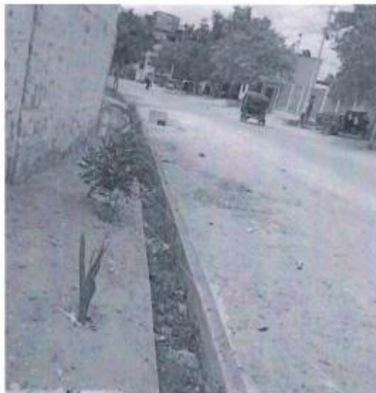
Figura 010. Cuneta rectangular de concreto obstruida – Tramo 1-364. Fuente: Equipo Consultor
