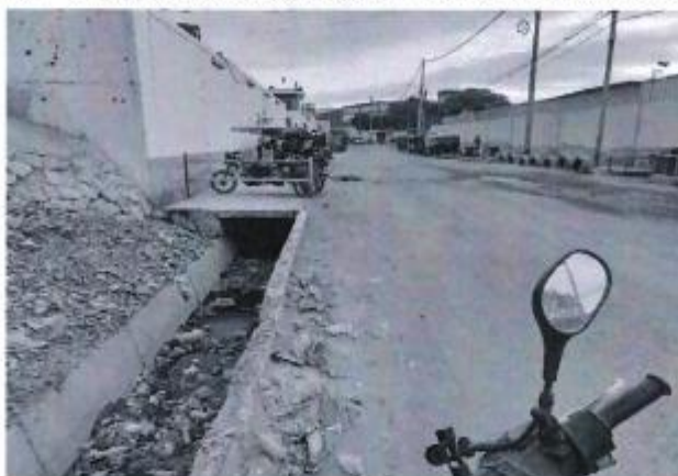
Figura 017. Cuneta trapezoidal obstruida – Tramo 1-369. Fuente: Equipo Consultor
