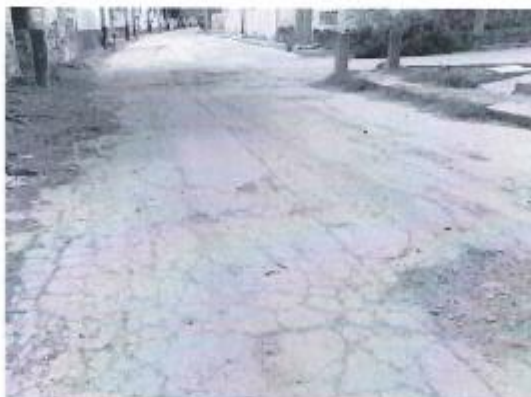
Figura 018. Pavimento Rígido con fisuras – Tramo 1-372. Fuente: Equipo Consultor
