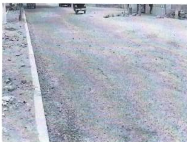
Figura 012. Desgaste en Pavimento Flexible K1+450 – Tramo 1-365. Fuente: Equipo Consultor
