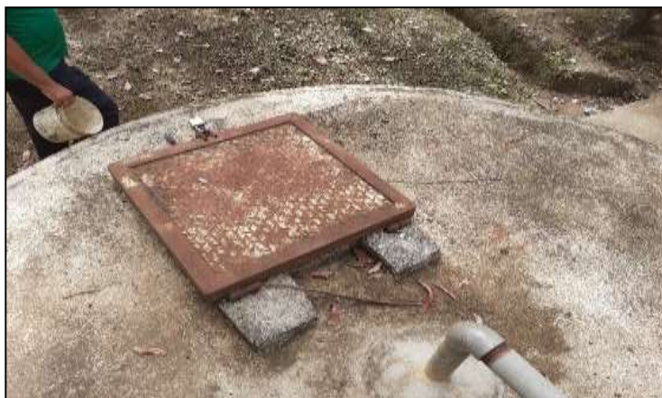
Foto N° 08: Cajas de válvulas inoperativas
