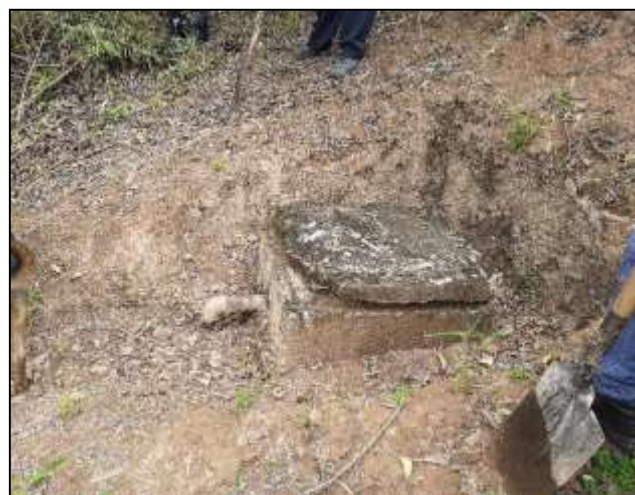
Foto N° 02 y 03: Línea de conducción expuesta y CRPT-6 abandonada
