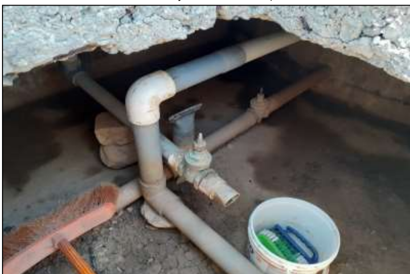
Foto N° 08: Cajas de válvulas inoperativas
