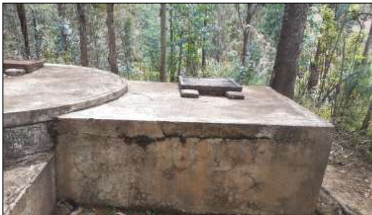
Foto N° 06 y 07: Tapas metálicas oxidadas
