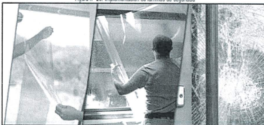
Figura n° 26: Implementación de láminas de seguridad
