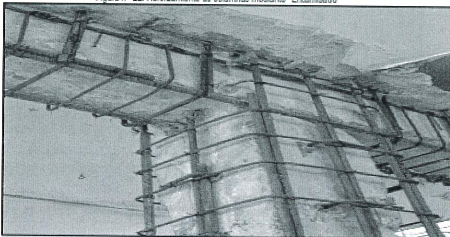
Figura n° 22: Reforzamiento de columnas mediante "Encamisado"
